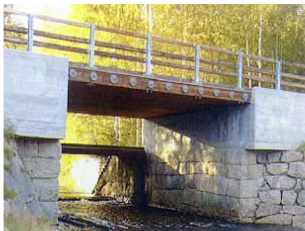
Slika 5. Mattisdammen most, poprečno prednapeta drvena ploča
