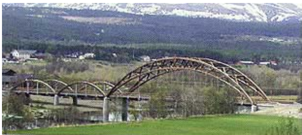
Slika 9. Bočni pogled na Tynset most, (rasponi 70+28+28 m)
