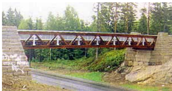
Slika 6. Nesoddevegen most, drveni rešetkasti pješački most
