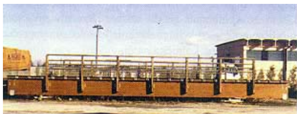
Slika 3. Most izveden na privremenoj lokaciji
