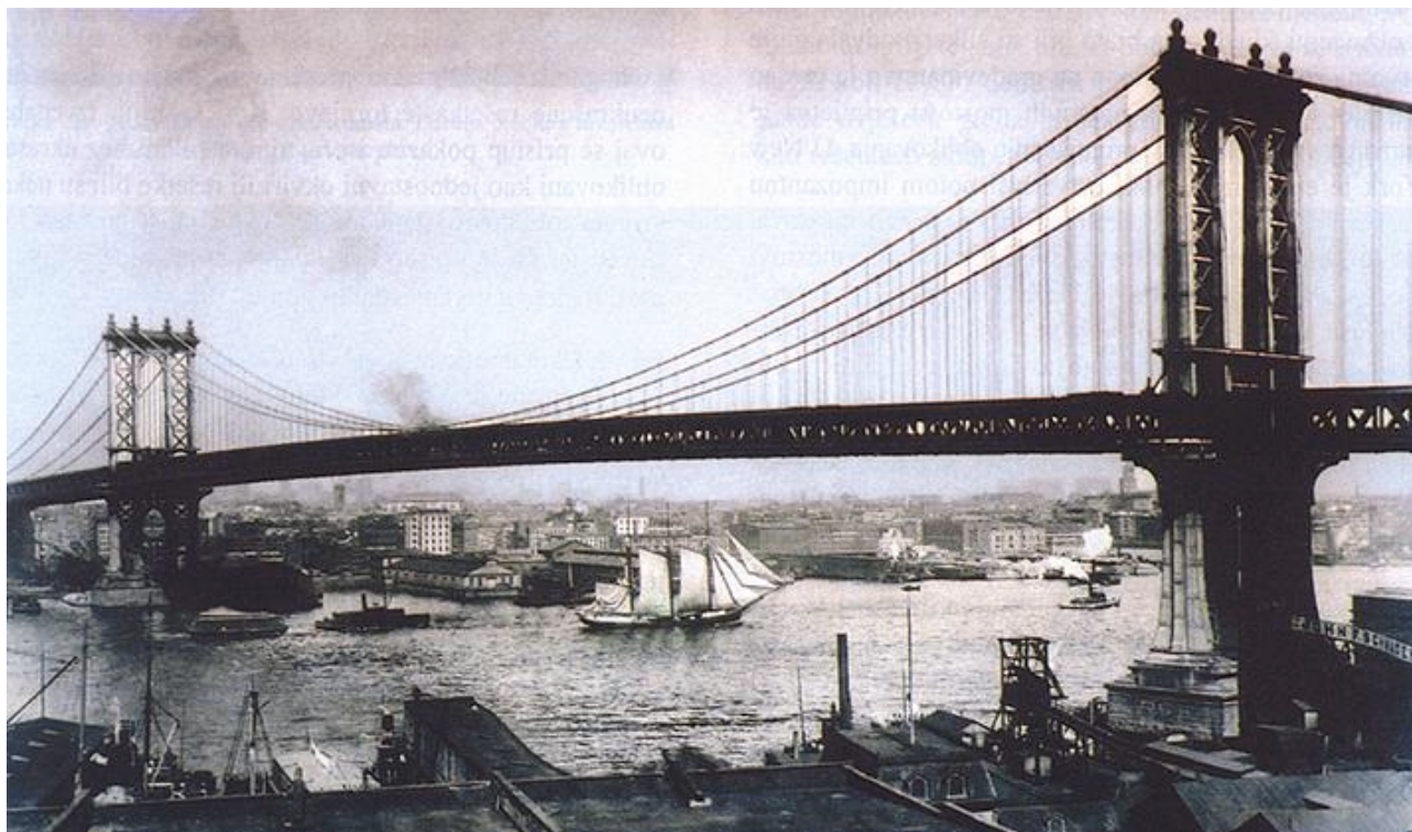
Slika 18. Most Manhattan, iz 1909., fotografija iz vremena neposredno nakon izgradnje. Dim na polovici raspona diže se iz lokomotive gradske željeznice
