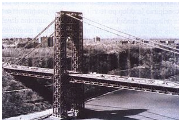
Slika 20. Pogled na most George Washington
