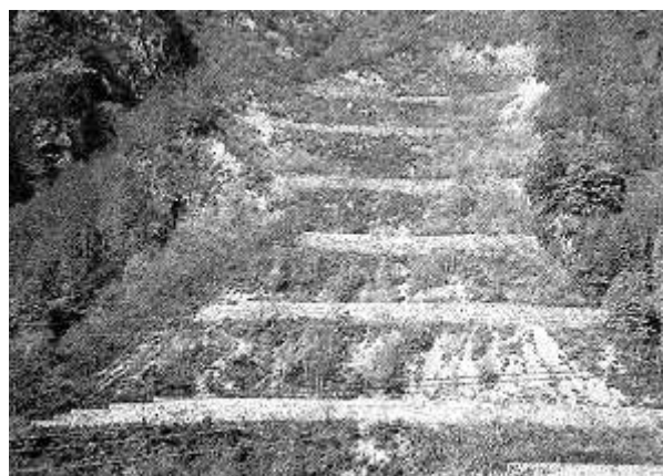
Slika 13. Sanirano klizište primjenom gabionskih konstrukcija
