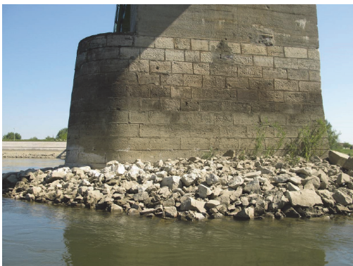
Slika 1. Riprap zaštita oko stupa mosta
