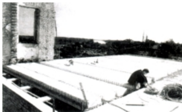
Slika 2. Izvedba Omnia -stropa sa štednim ulošcima, na gimnaziji u Vukovaru
