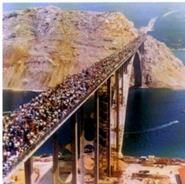
Slika 13. Početak i završetak gradnje mosta
