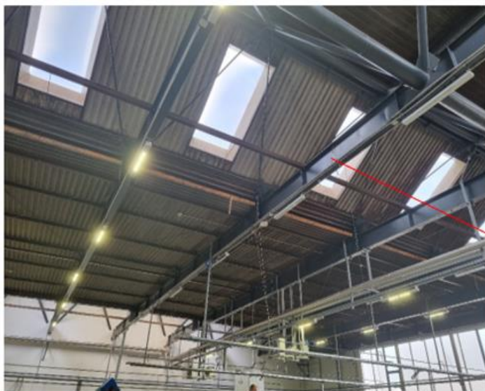
Slika 5.4 Fotografija sekundarnog nosača krovne konstrukcije
