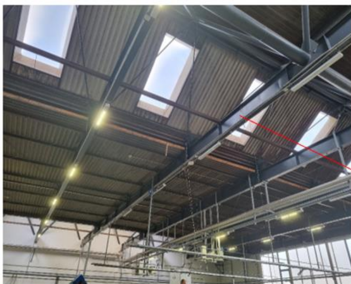
Slika 5.4 Fotografija sekundarnog nosača krovne konstrukcije
