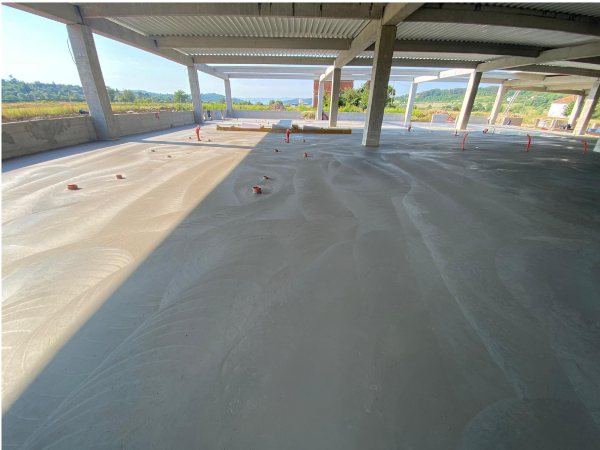
Slika 37 Podna ploča nakon završne obrade helikopterima.
