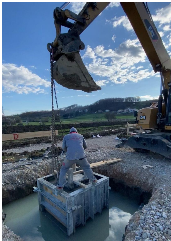
Slika 20 Izvlačenje unutarnje oplata temeljne čašice
