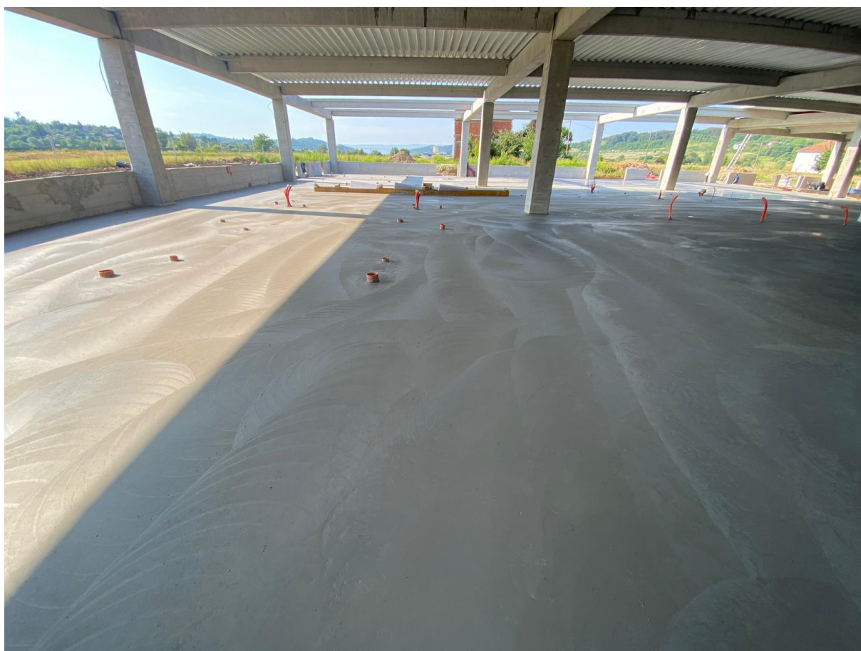
Slika 37 Podna ploča nakon završne obrade helikopterima.
