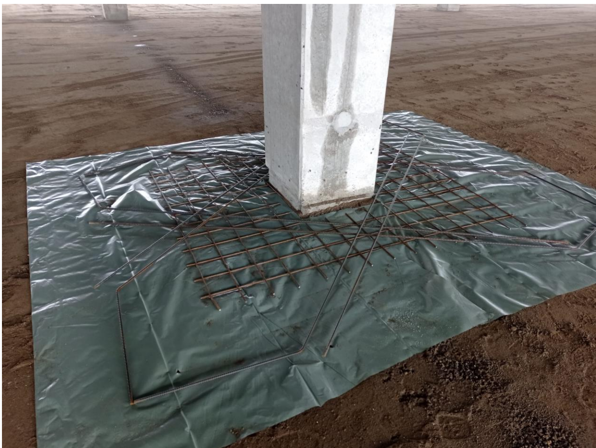
Slika 36 Armatura oko stupova
