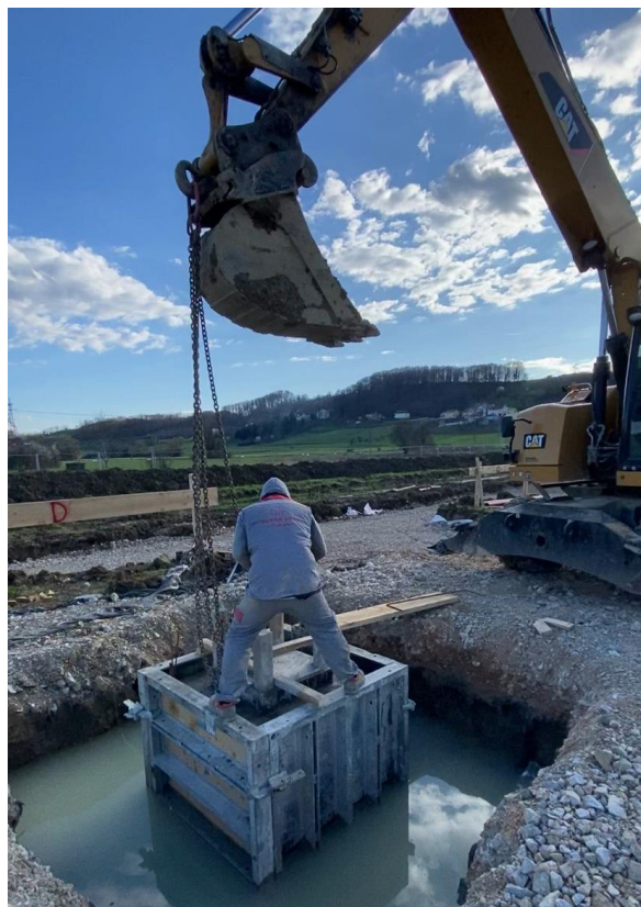
Slika 20 Izvlačenje unutarnje oplata temeljne čašice
