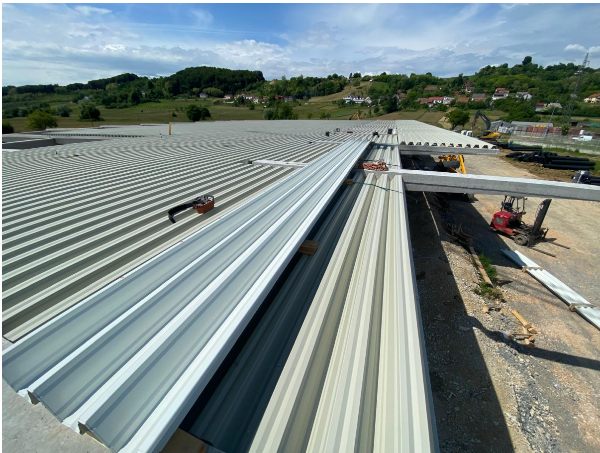
Slika 40 Montirani krovni čelični lim
