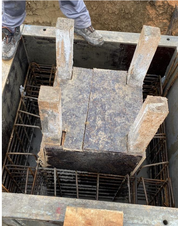
Slika 19 Unutarnja oplata temeljne čašice
