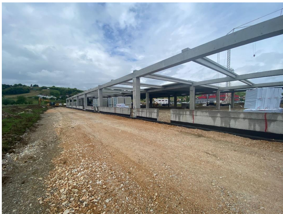
Slika 34 Završena AB montažna konstrukcija
