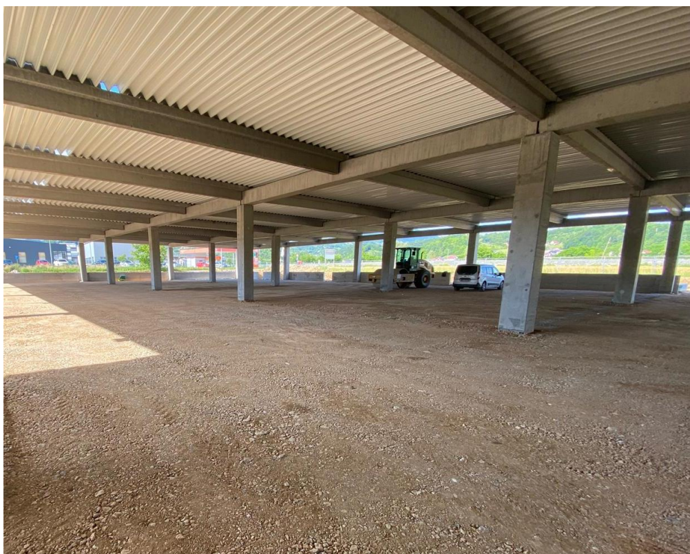
Slika 35 Podloga pripremljena za AB ploču
