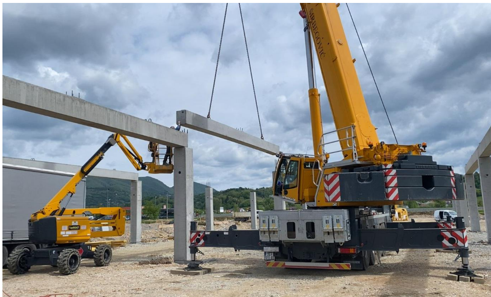
Slika 33 Montaža glavnih krovnih nosača
