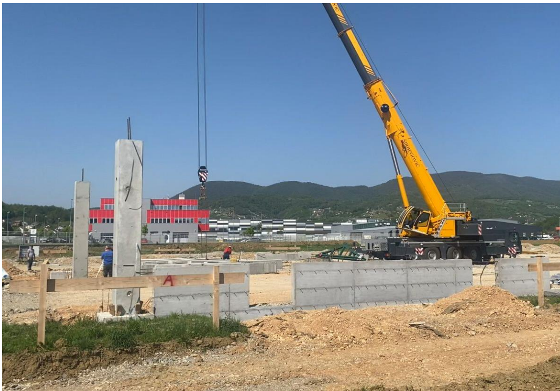
Slika 32 Montaža AB stupova
