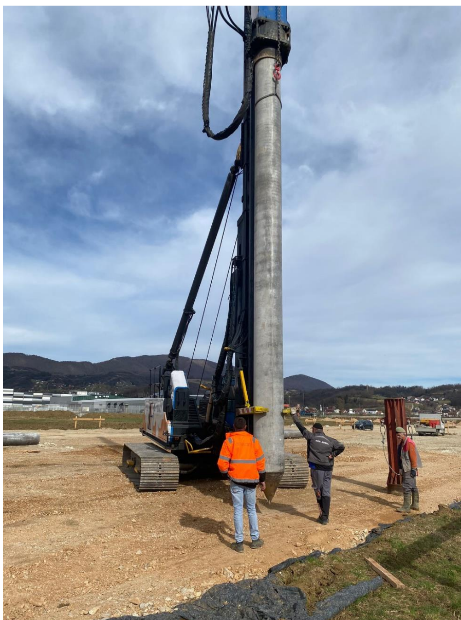
Slika 12 Junttan PM20 neposredno pred početak pobijanja
