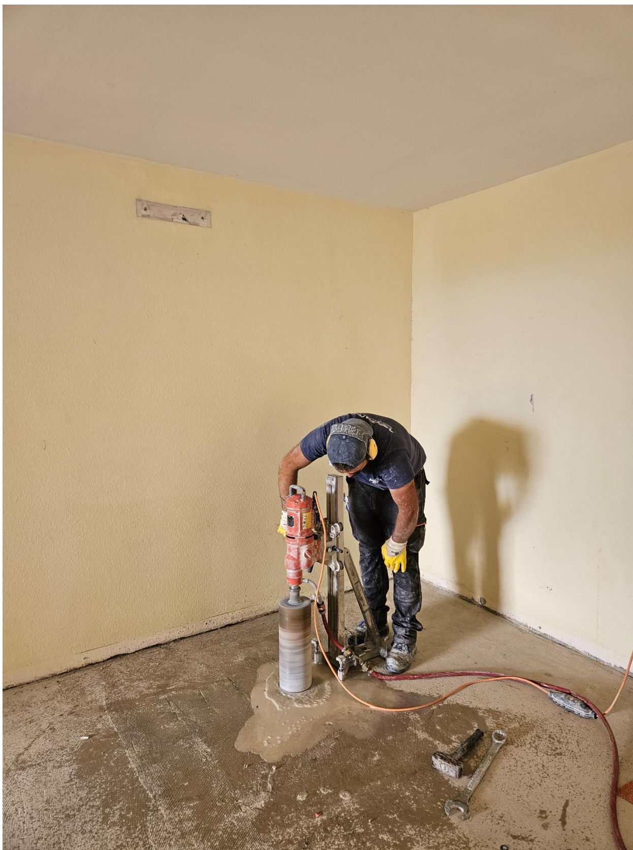
Slika 19. Rezanje uzorka iz AB stropne ploče
