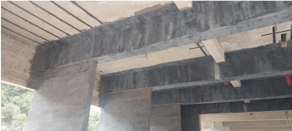
Slika 2. Fotografija ojačanja lamelama i karbonskim platnom na gradilištu [30.05.2024.]
