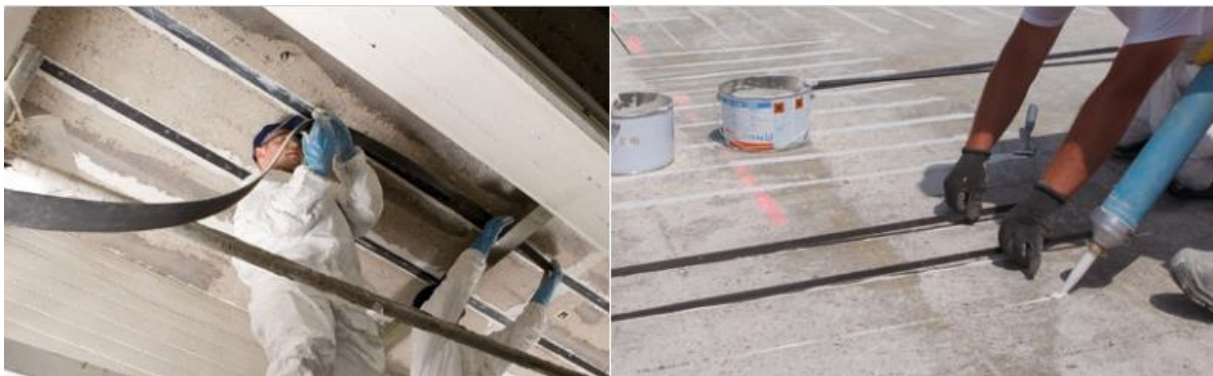
Slika 1. Lijepljenje CFRP lamela [6]
