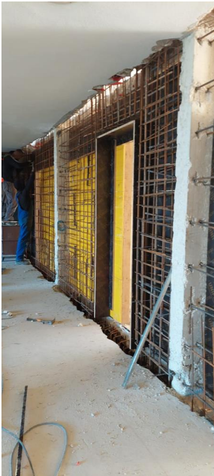
Slika 6. Postavljanje i povezivanje armature zidova ojačanja
