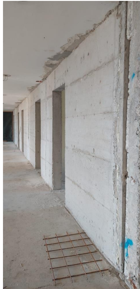
Slika 7. Novi AB zid ojačanja konstrukcije
