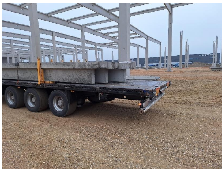
Slika 33: Dovoz sekundarnih nosača
