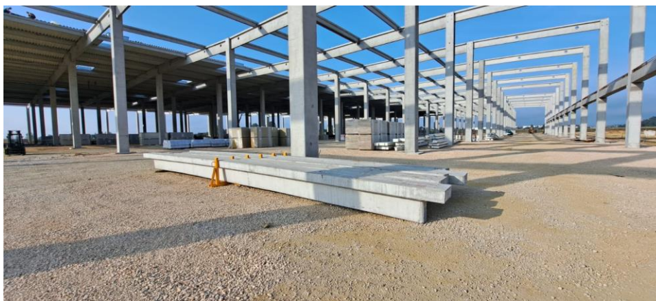
Slika 30: Deponiranje sekundarnih nosača na gradilištu
