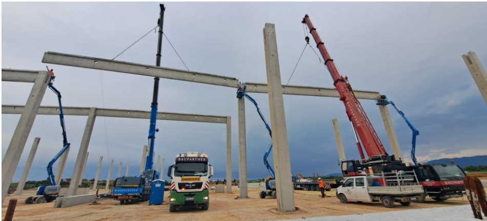
Slika 11: Polaganje glavnih nosača
