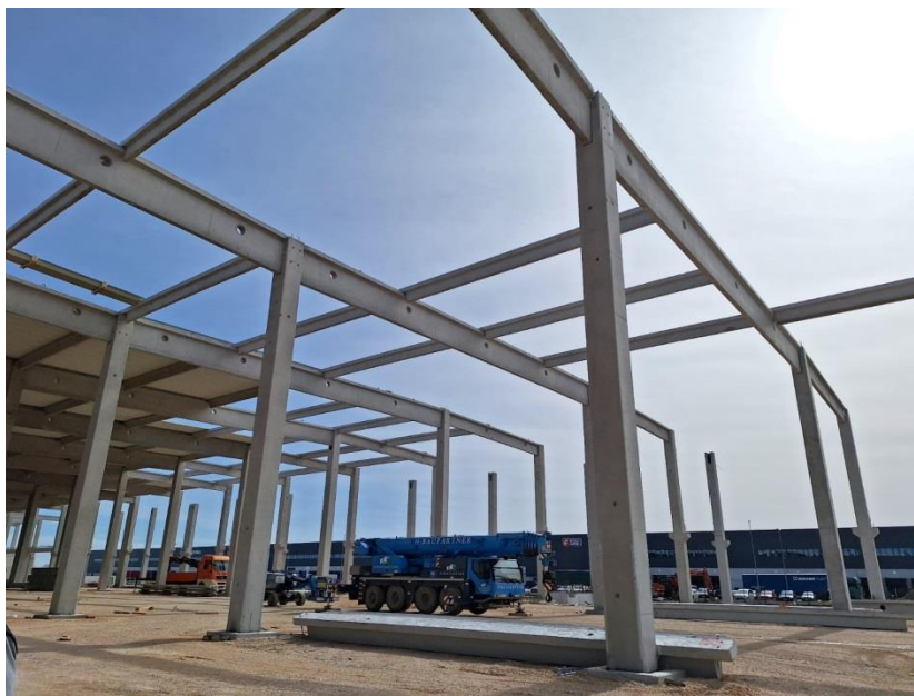
Slika 13: Sekundarni nosači
