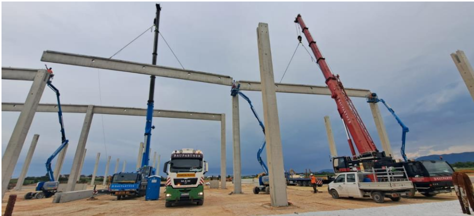
Slika 11: Polaganje glavnih nosača
