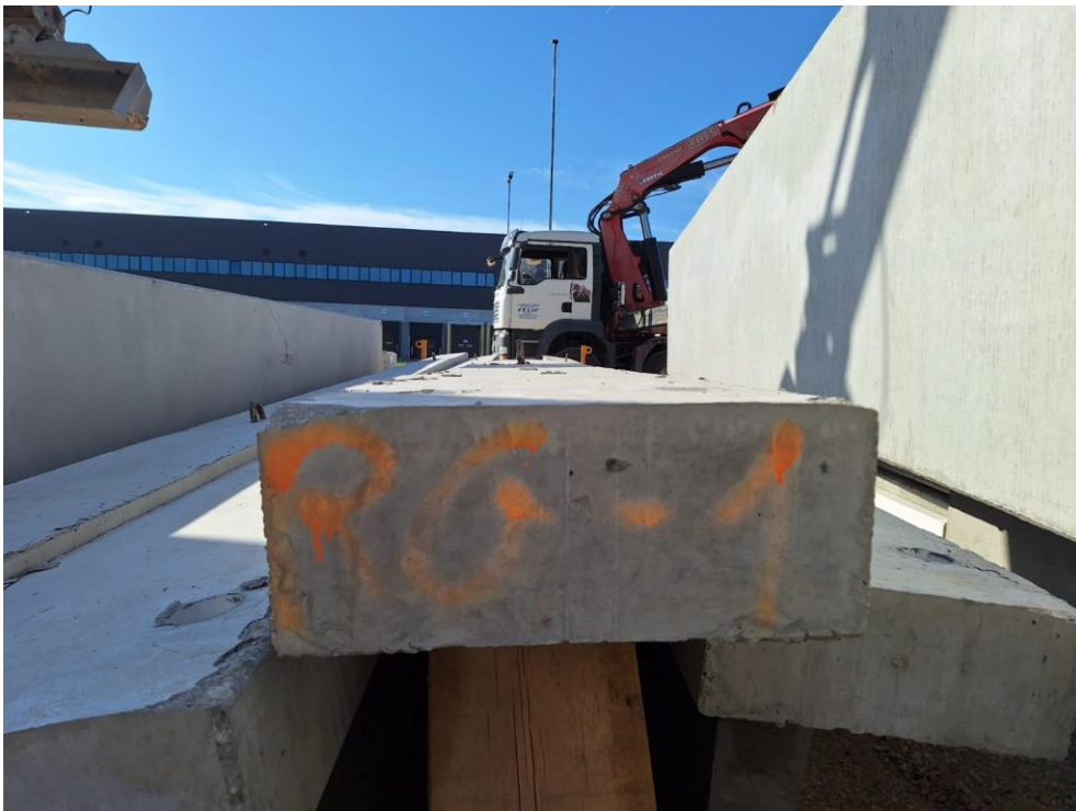
Slika 10: Deponirana rubna greda
