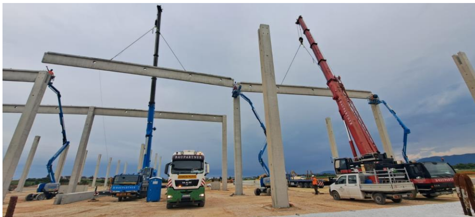
Slika 36: Montaža glavnih nosača
