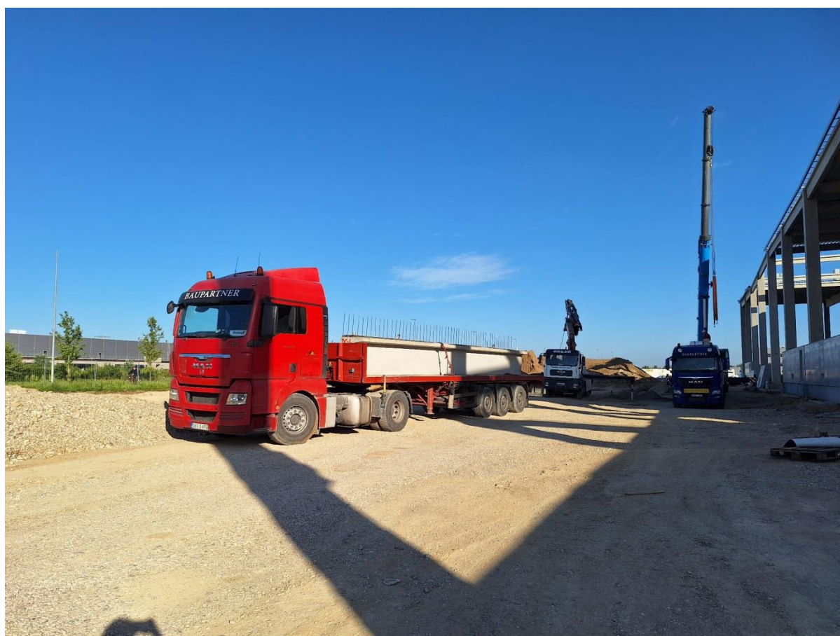
Slika 34: Dovoz etažnih greda
