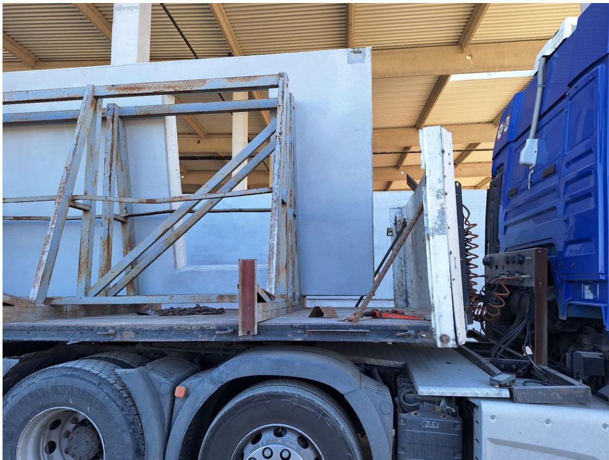
Slika 35: Dovoz fasada
