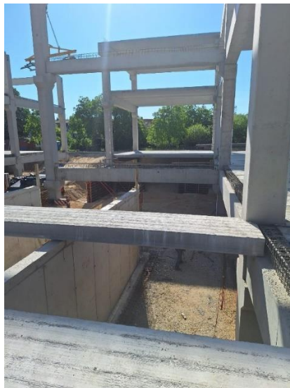
Slika 6: Šuplje predgotovljene ploče PPB300
