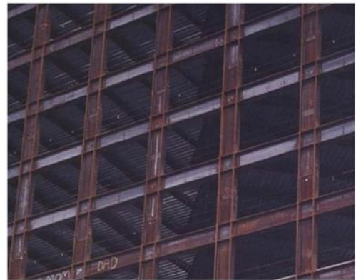
Slika 2.7. Savijanje nosača i stupova kod okvirnog sustava [1]
