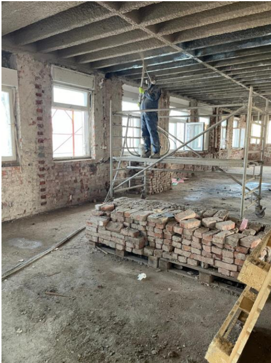
Slika 39.: Ispravno korištenje skela na kotačima
