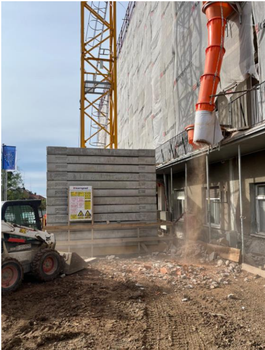
Slika 32.: Zaštitna ograda oko postolja dizalice sa pločom opasnosti i obavijesti
