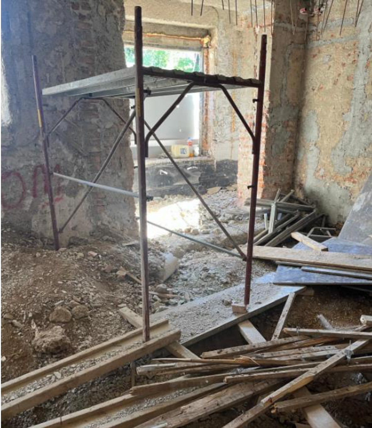
Slika 43.: Nestabilna skela i skela bez zaštite od pada s visine
