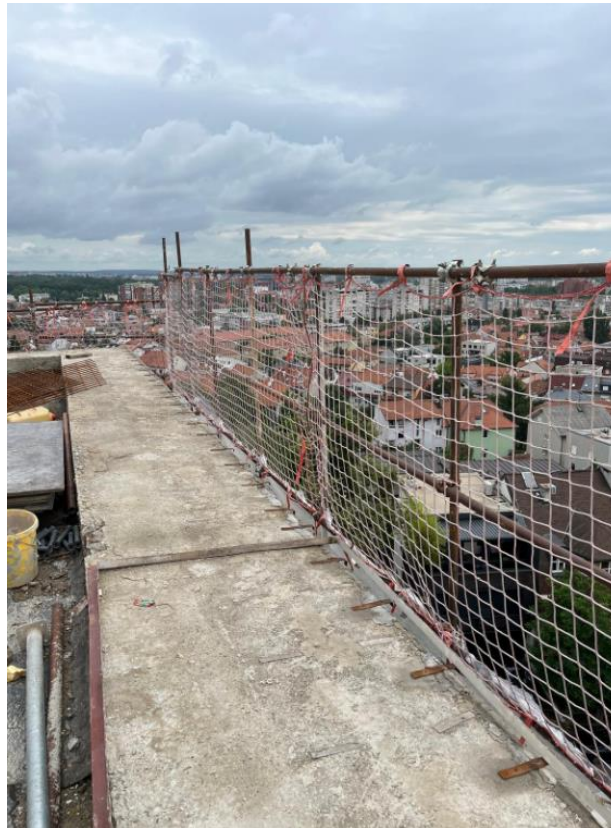
Slika 24.: Ograda na južnom dijelu krova
