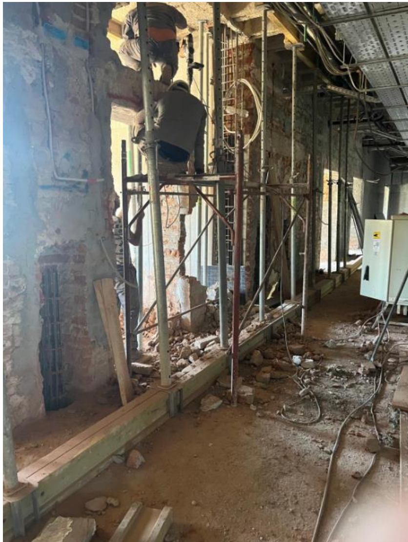
Slika 42.: Skela bez ograde i podnice
