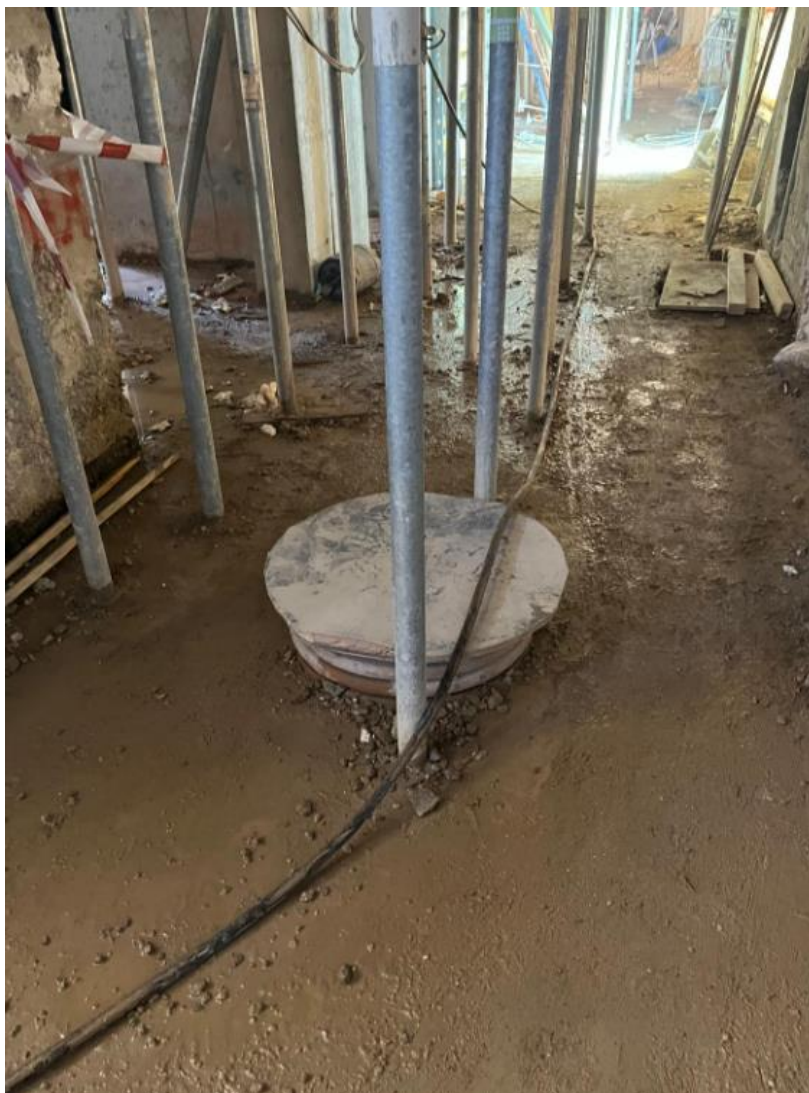
Slika 33.: Zaštita postavljena na otvor šahta
