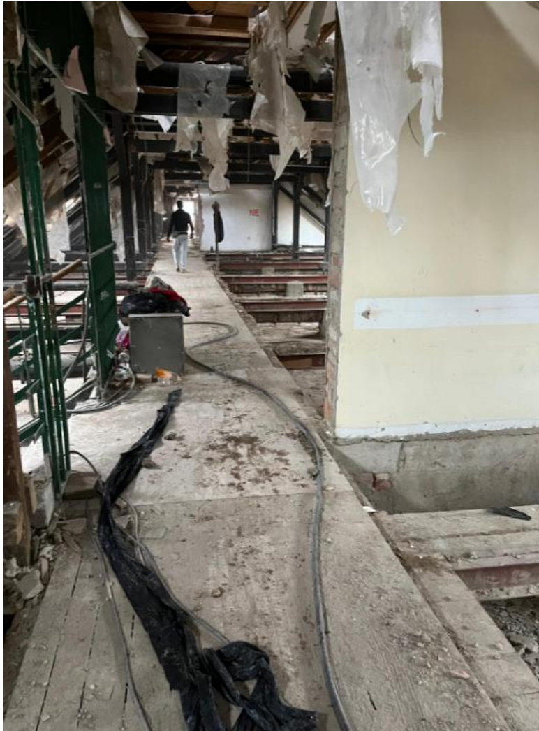
Slika 17.: Krovna konstrukcija tijekom uklanjanja
