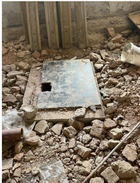
Slika 35.: Zaštita postavljena na otvor šahta
