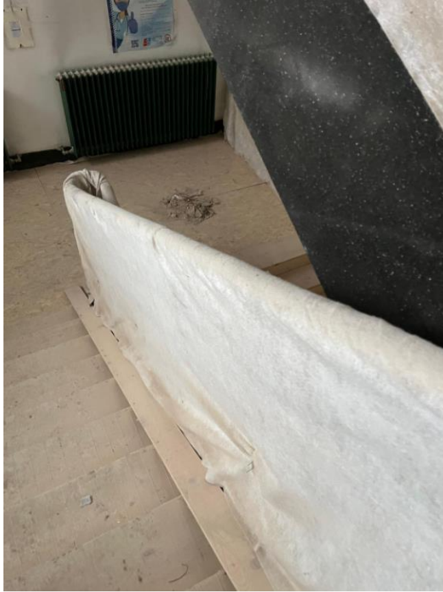
Slika 7.: Zaštićena ograda i rukohvat
