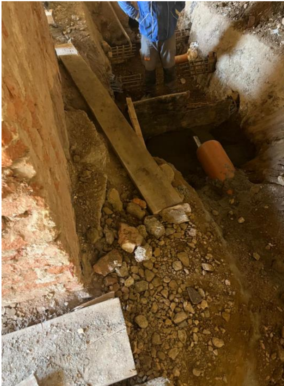
Slika 44.: Daska kao rampa za prijelaz
