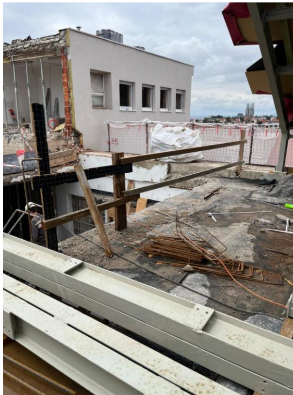
Slika 29.: Zaštita od pada
