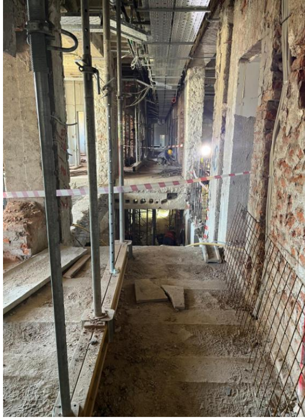
Slika 30.: Traka za označavanje opasne zone
