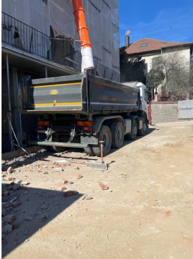
Slika 19.: Cijev za šutu i odvoz kamionom
