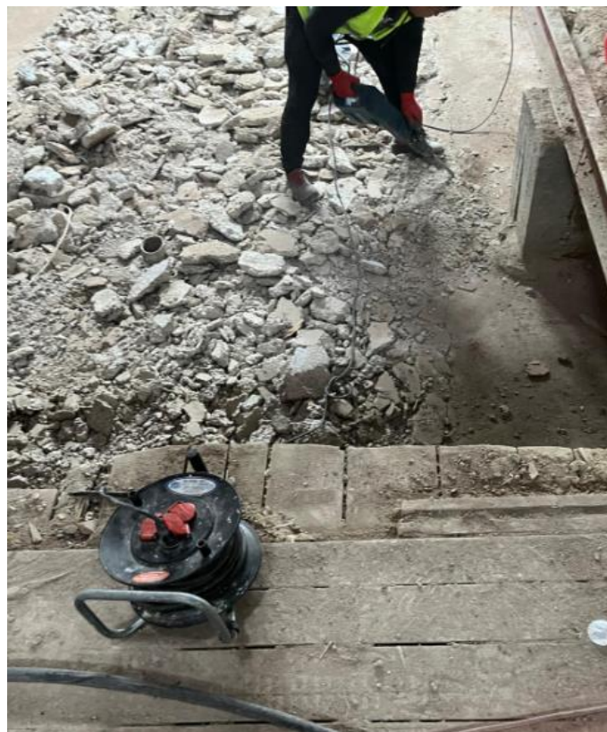
Slika 18.: Uklanjanje slojeva poda
