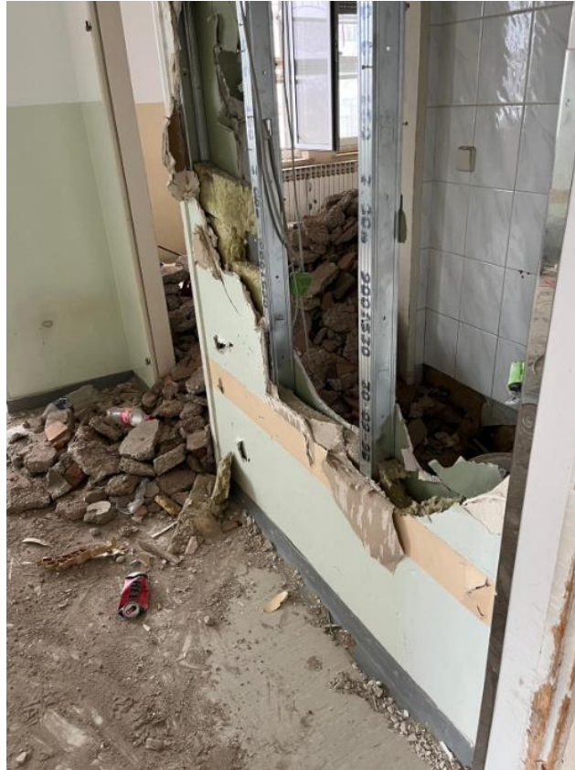
Slika 20.: Uklanjanje svih dodatnih opterećenja
