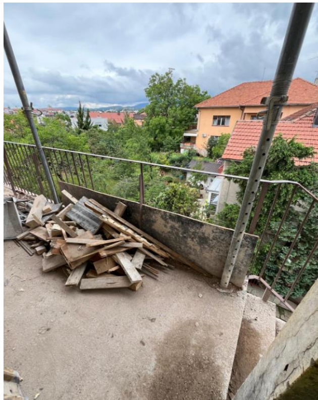
Slika 25.: Postavljena improvizirana barijera
