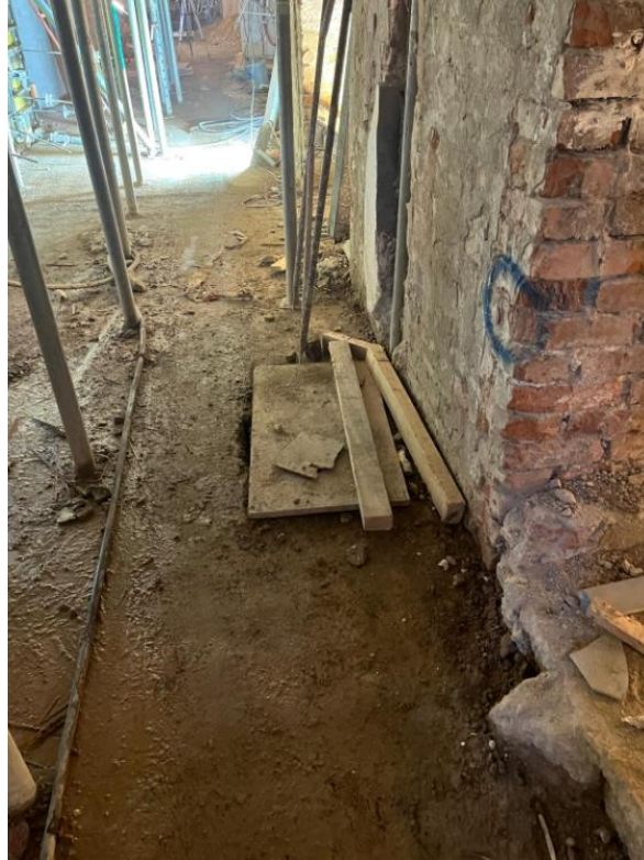
Slika 34.: Postavljena daska za zaštitu od pada i ozlijede
