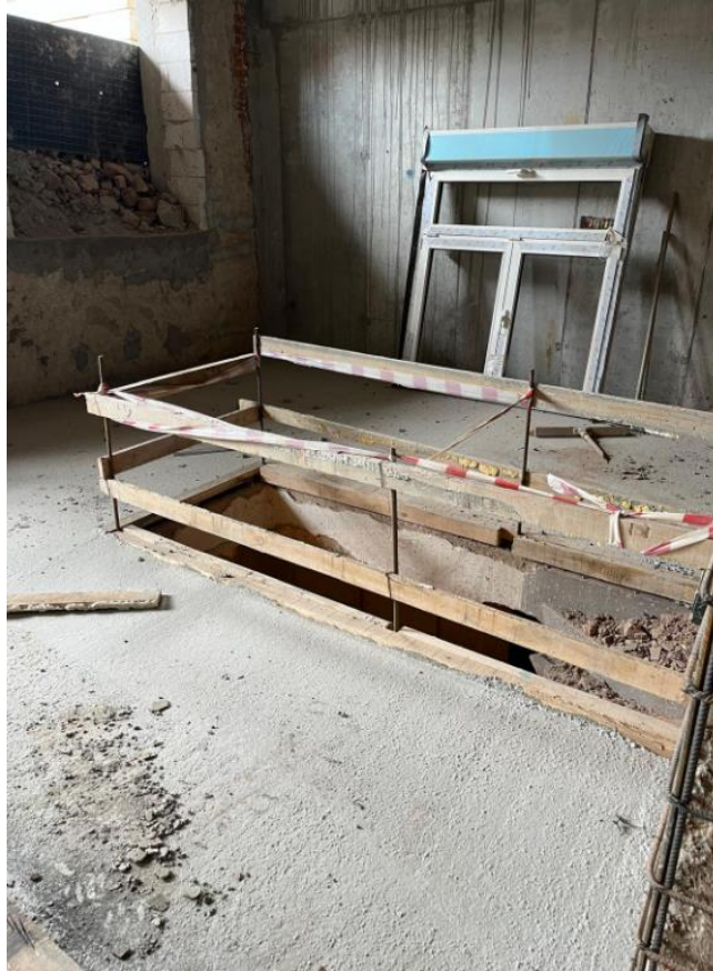
Slika 28.: Zaštitna ograda
