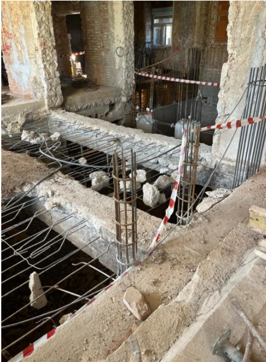
Slika 41.: Nepravilno ograđivanje opasnog područja trakom
