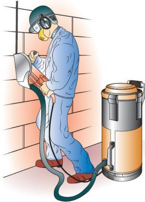
Slika 16: Dobra kontrola uklanjanja prašine i korištenje maske za potpunu zaštitu (Hughes i Ferrett, 2016)
