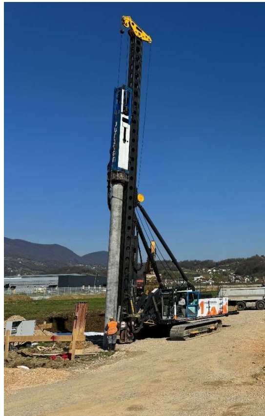
Slika 32. Pilot spreman za zabijanje
