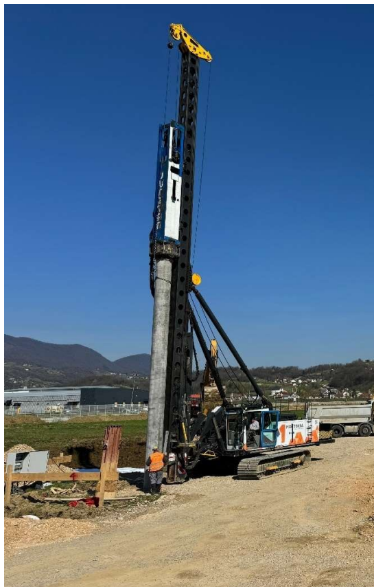
Slika 32. Pilot spreman za zabijanje
