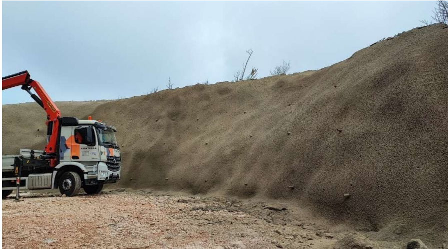
Slika 10. Zaštita pokosa mlaznim betonom
