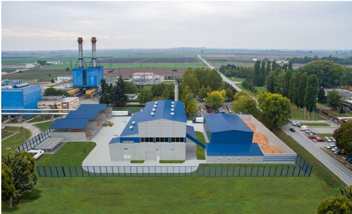
Slika 14.: Bioelektrana-toplana Osijek (HEP, n.d. c)
