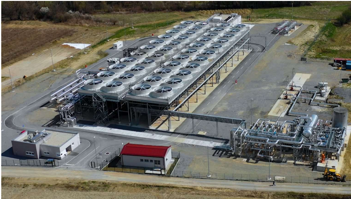
Slika 15.: Geotermalna elektrana „Velika 1“ (OIE Hrvatska, 2019)
