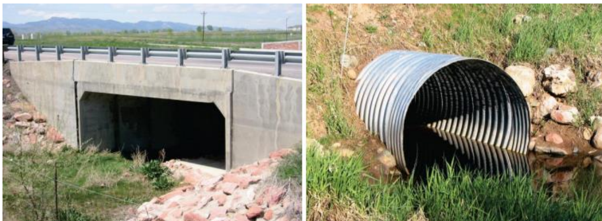
Slika 5 Različiti oblici propusta [13]
