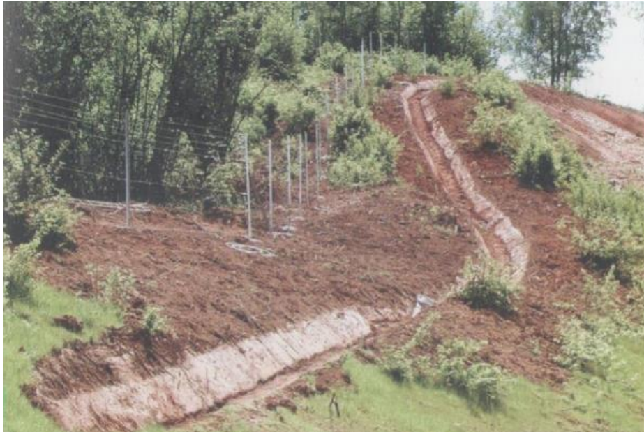
Slika 12 Zaštitni jarak [4]
