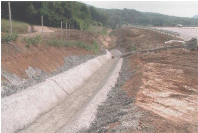
Slika 9 Trapezni odvodni jarak [14]
