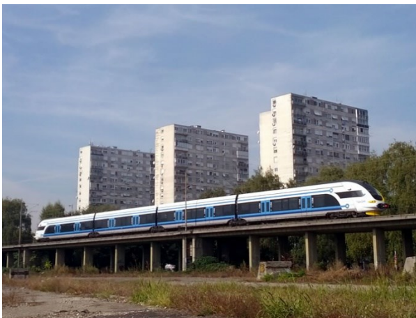
Željeznički nadvožnjak u istočnom dijelu grada Zagreba
