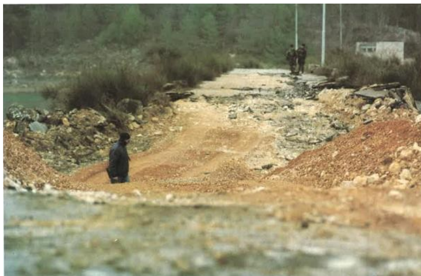
Slika 9: Krater na desnom kraju brane (Izvor: [4])
