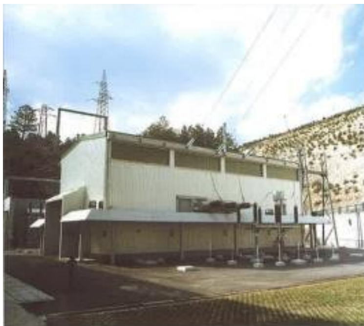
Slika 6: Rasklopno postrojenje HE Peruća (Izvor: [2])
