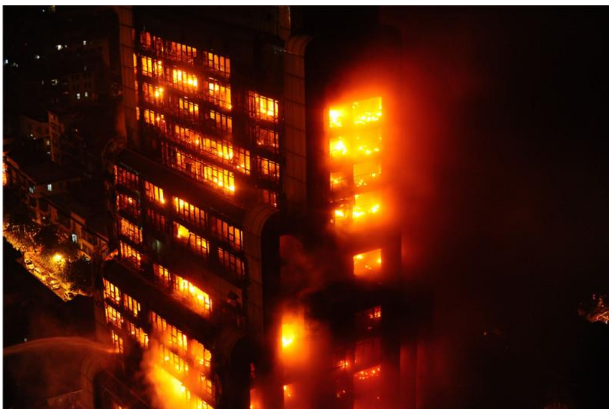
Slika 2.1.1 Zgrada prilikom požara [31]
