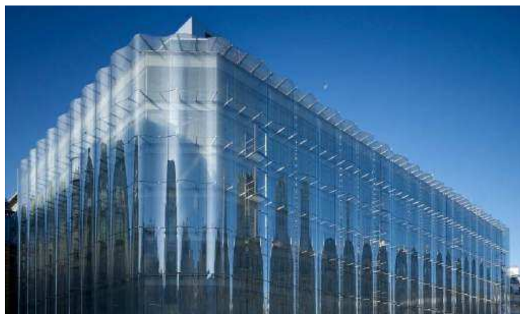
Slika 41: Novi dio zgrade (Izvor:[70])
