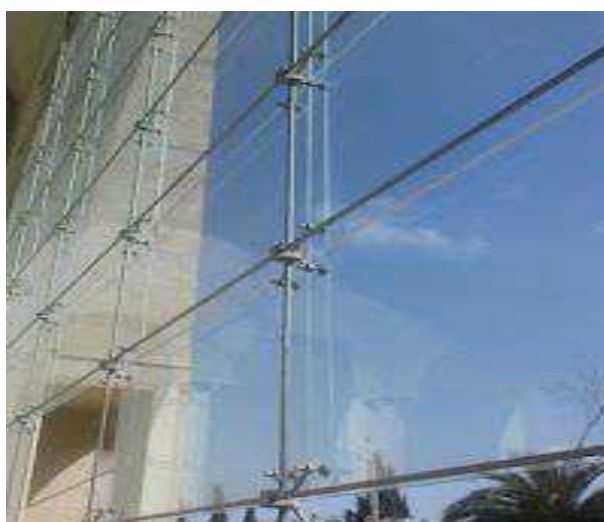
Slika 34: Primjer spider obloge (Izvor: [60])
