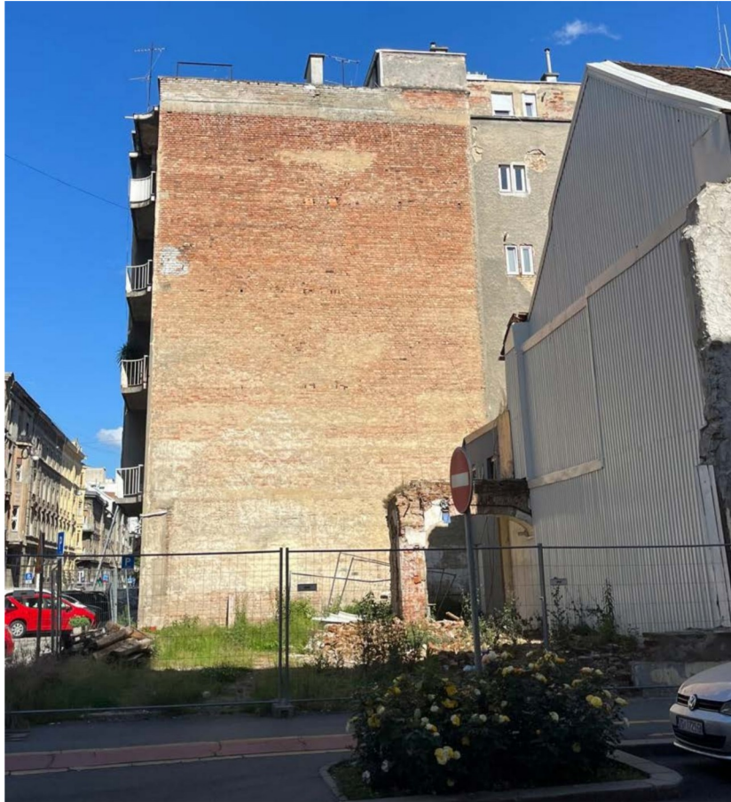
Slika 46: Zgrada na adresi Petrinjska ul. 25 nakon potresa je srušena zbog velikih oštećenja
