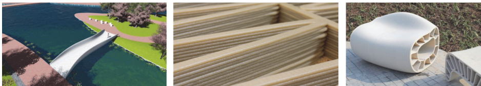
Slika 2. Prvi 3d printani most u Kini, Shanghai [14]
