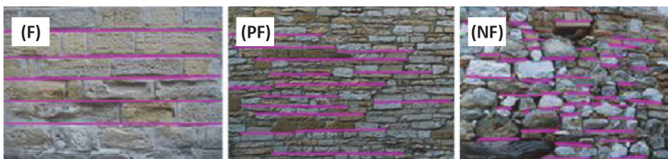
Slika 3. Kontinuiranost horizontalnih sljubnica [5]
