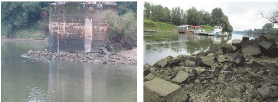
Slika 2. Riprap zaštita od podlokavanja savskog mosta u Jasenovcu, pogled nizvodno prema stupu (lijevo) i detalj iste lokacije (desno)
