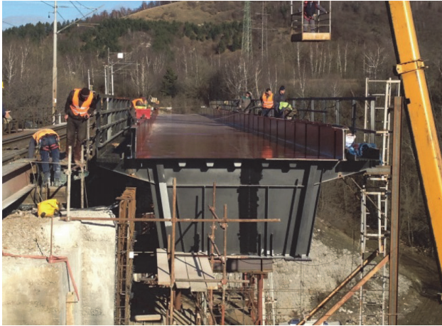
Slika 3. Čelična konstrukcija mosta, faza izvedbe
