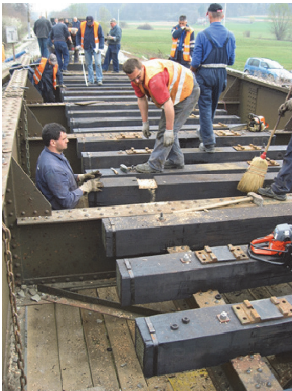
Slika 2. Pojedinačna obrada drvenih pragova na čeličnome mostu
