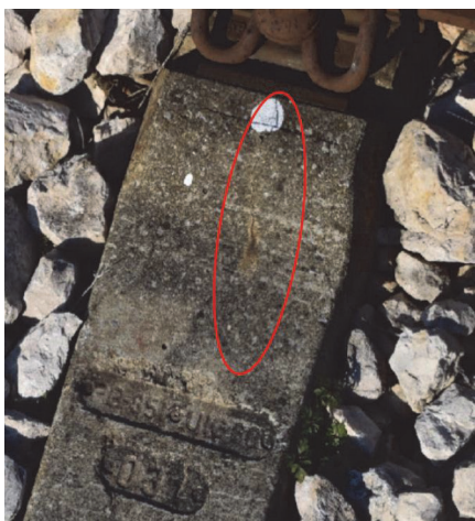
Slika 4. Pukotina TIP 1
