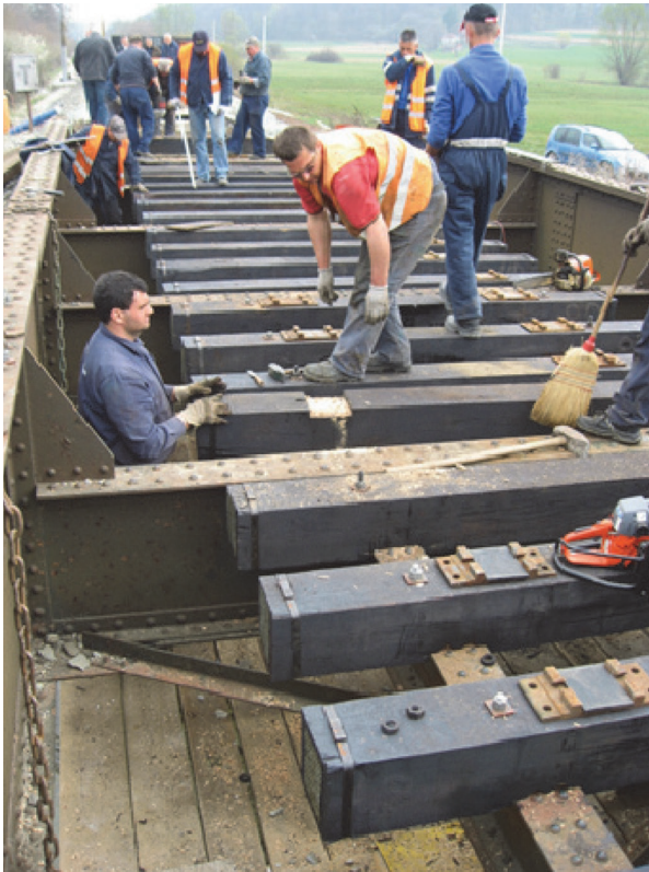
Slika 2. Pojedinačna obrada drvenih pragova na čeličnome mostu
