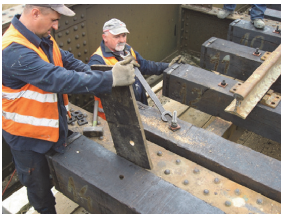
Slika 1. Pričvršćivanje drvenih pragova na čeličnu mosnu konstrukciju
