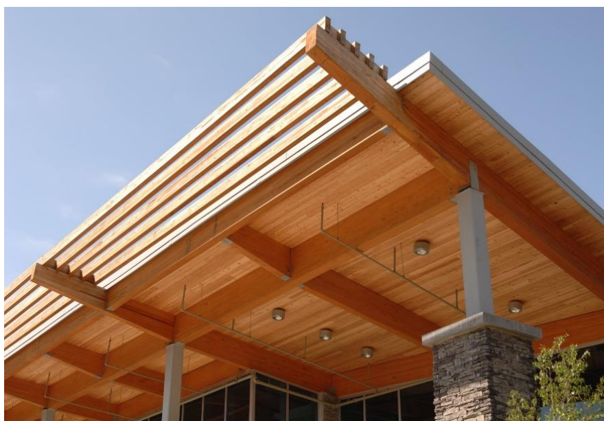
Slika 3.1. Primjer statički neodređenog nosača u praksi (Izvor:[ http://unalam.blogspot.com/2015/10/girder-wednesdays-word-of-week.html ])
