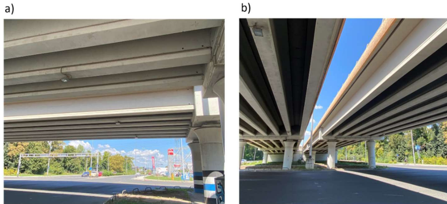
Slika 19.: Podvožnjak rasvijetljen a) reflektorima b) otvorom u konstrukciji na Slavenskoj Aveniji (Izvor: autor)
