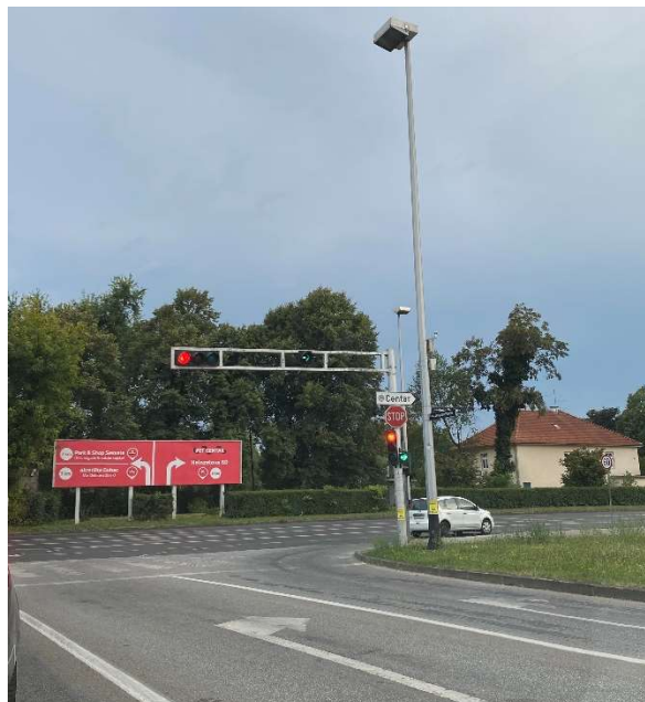
Slika 16.: Primjer lošeg postavljanja rasvjetnog stupa na križanju Ulice Kneza Branimira i Ulice Dragutina Mandla (Izvor: autor)
