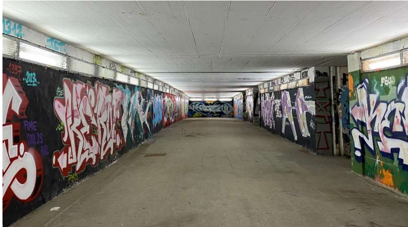
Slika 21.: Rasvjetljenje pothodnika u Ulici Kneza Branimira (Izvor: autor)
