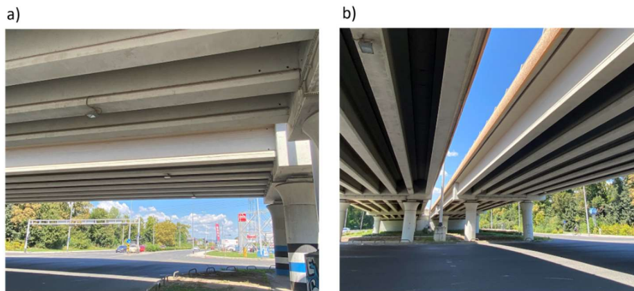
Slika 19.: Podvožnjak rasvijetljen a) reflektorima b) otvorom u konstrukciji na Slavenskoj Aveniji (Izvor: autor)
