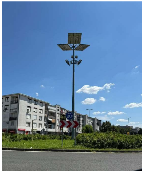
Slika 17.: Kružni tok osvijetljen jednim središnjim stupom u Ulici Vice Vukova (Izvor: autor)
