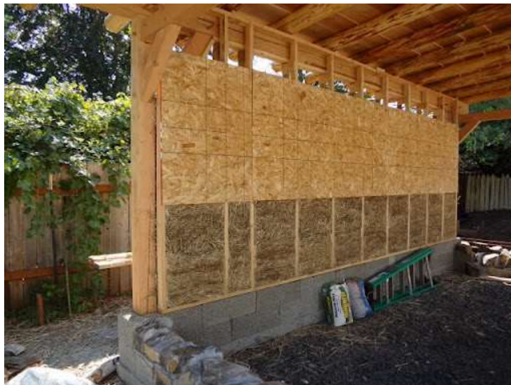
Slika 8: Zidna ispuna od gline i slame, Izvor: [40]
