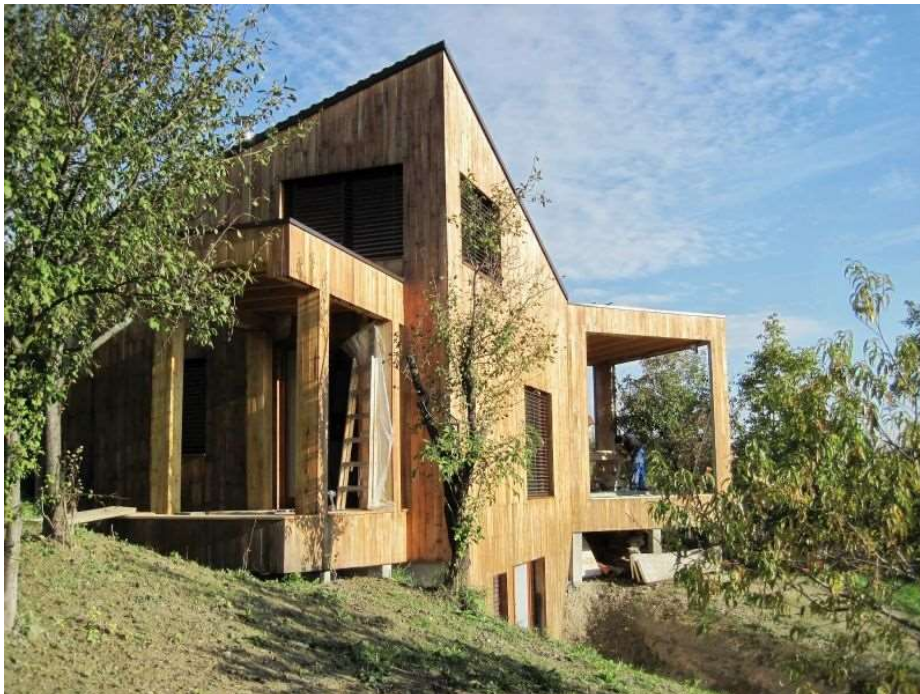
Slika 19: Građevina nakon završetka radova, Izvor: [58]
