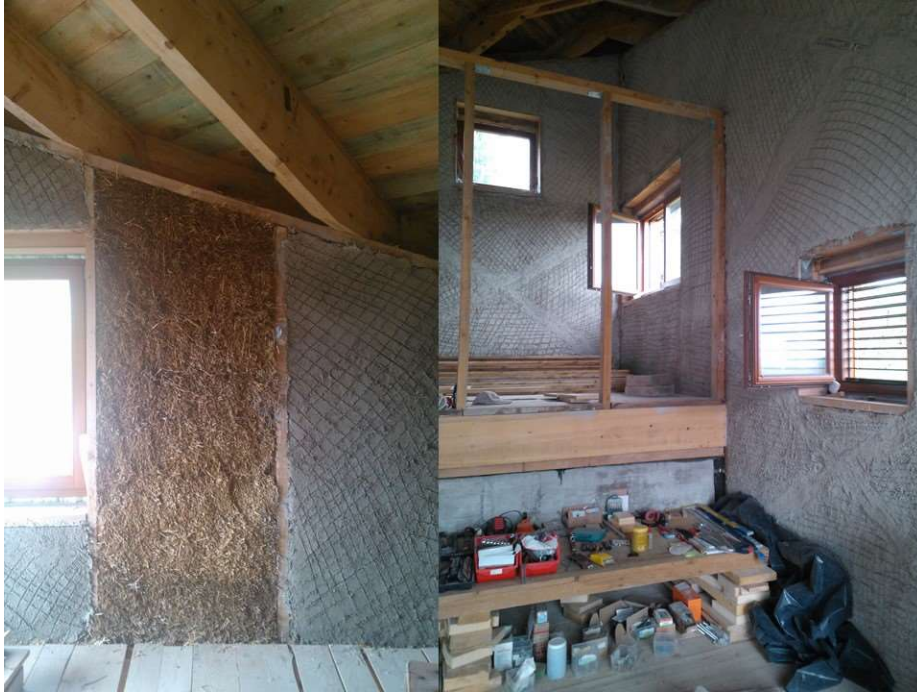
Slika 18: Unutarnji zidovi ispunjeni slamom te ožbukani glinenom žbukom, Izvor: [58]
