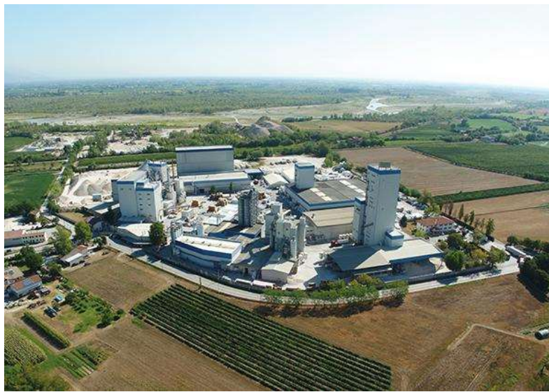
Slika 10: Tvornica vapna proizvođača Fassa Bortolo, Izvor: [50]
