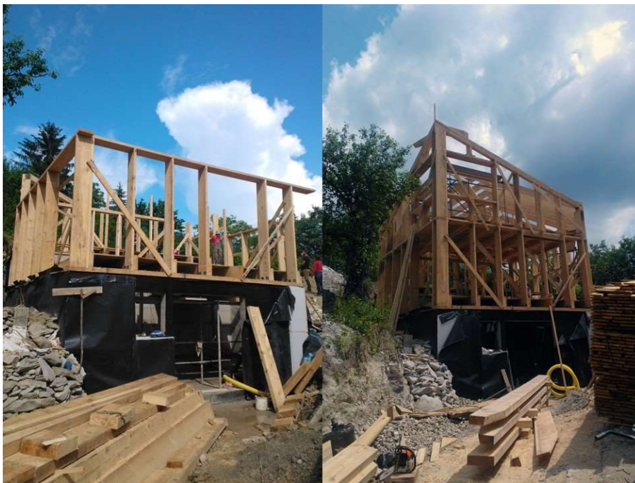
Slika 17: Drvena konstrukcija građevine, Izvor: [58]
