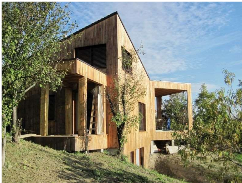
Slika 19: Građevina nakon završetka radova, Izvor: [58]
