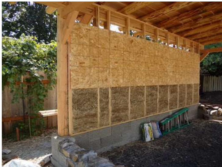
Slika 8: Zidna ispuna od gline i slame, Izvor: [40]
