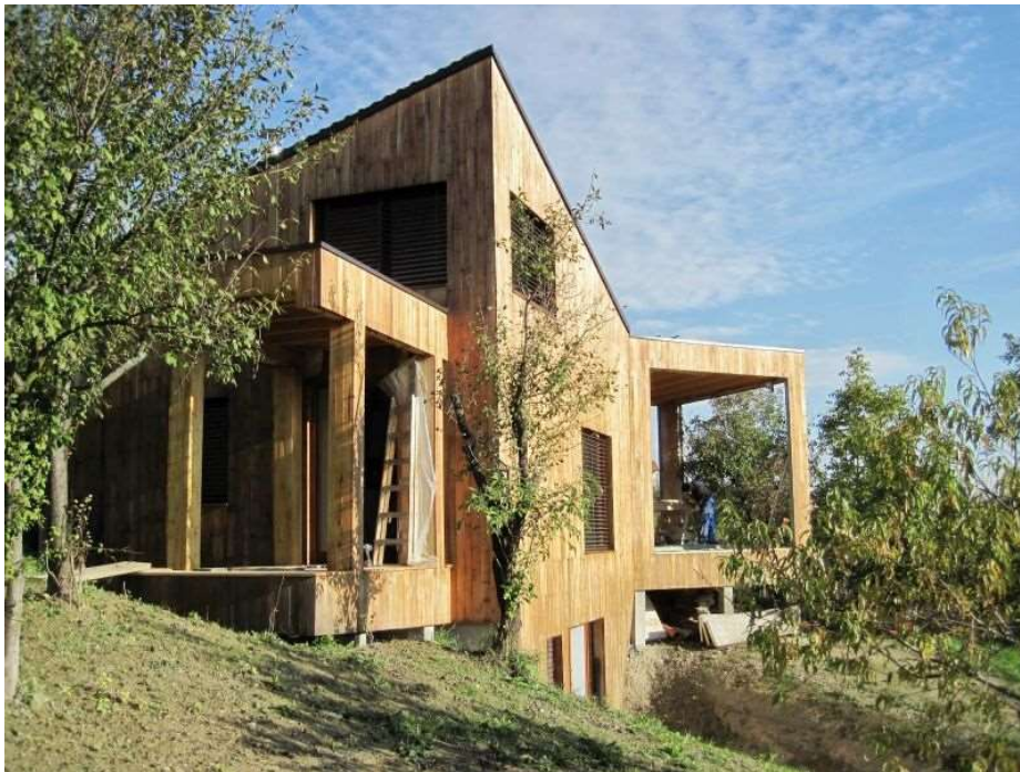
Slika 19: Građevina nakon završetka radova, Izvor: [58]
