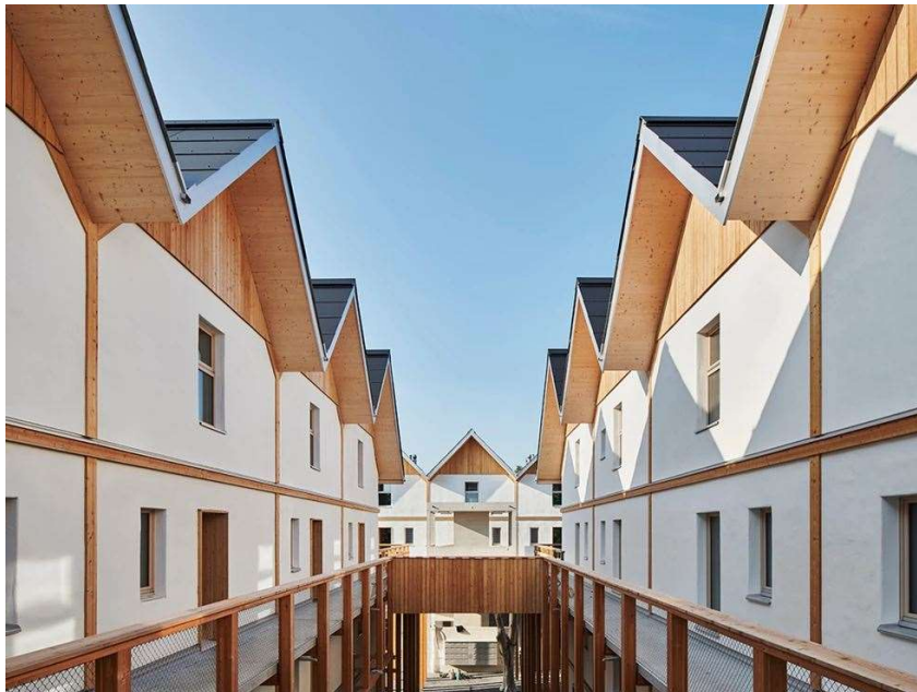
Slika 11: Stambeno naselje izgrađeno primjenom drvenih elemenata ispunjenih slamom, Nanikon, Švicarska, Izvor: [52]
