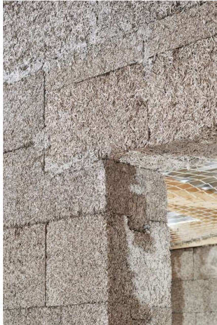
Slika 15: Hempcrete elementi od konoplje, Izvor: [55]
