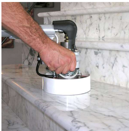
Slika 14: Poliranje kamena (Izvor: [28])
