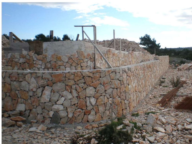
Slika 23: Primjer zida od kamena samca (Izvor: [35])
