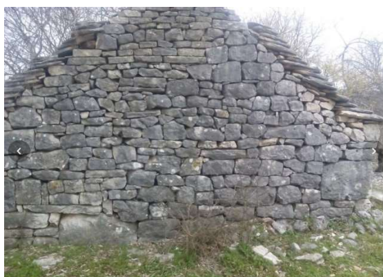
Slika 17: Primjer zida od običnog lomljenog kamena (Izvor: [30])
