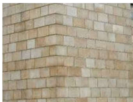
Slika 29: Primjer zida od fino obrađenog kamena (Izvor: [40])
