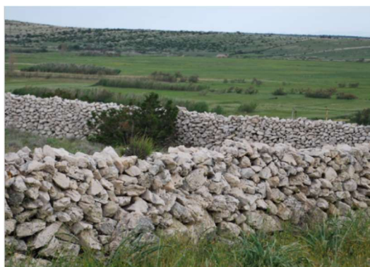
Slika 25: Primjer suhozida (Izvor: [38])
