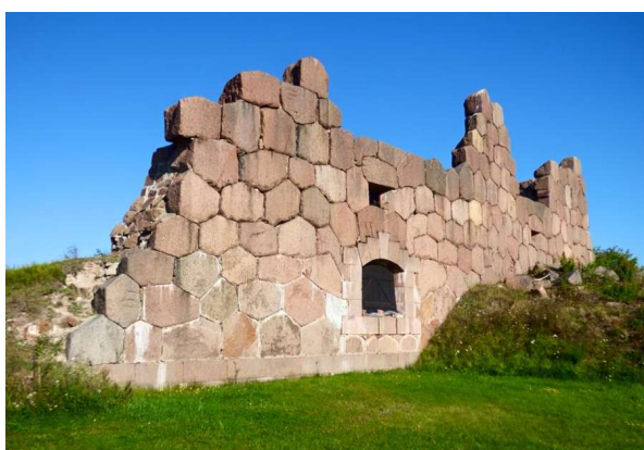
Slika 21: Primjer kiklopskog zida (Izvor: [34])
