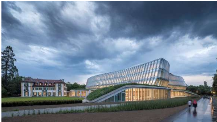
Slika 51: Vanjski izgled fasadnog sustava (Izvor: [51])
