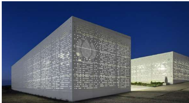
Slika 17: Fasadna obloga vlaknasto-cementnim panelima (Izvor:[19])
