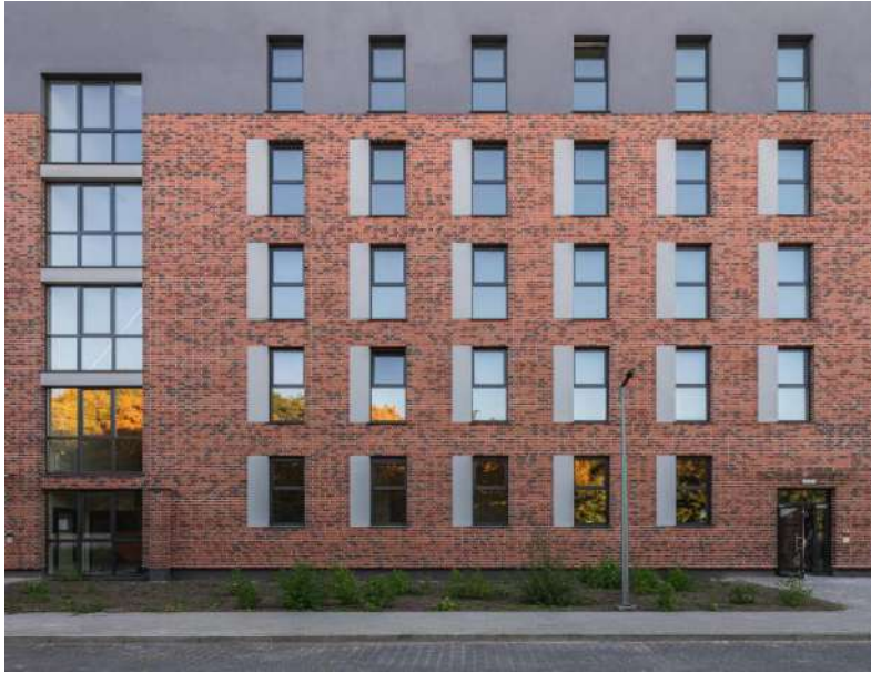
Slika 10: Fasadna obloga klinker opekom ( Izvor:[12] )
