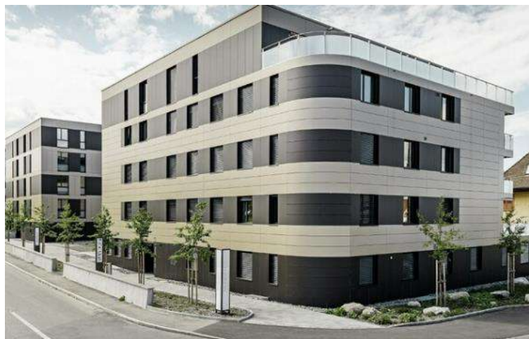
Slika 21: Fasadna obloga aluminijskim kompozitnim pločama ( Izvor: [24] )
