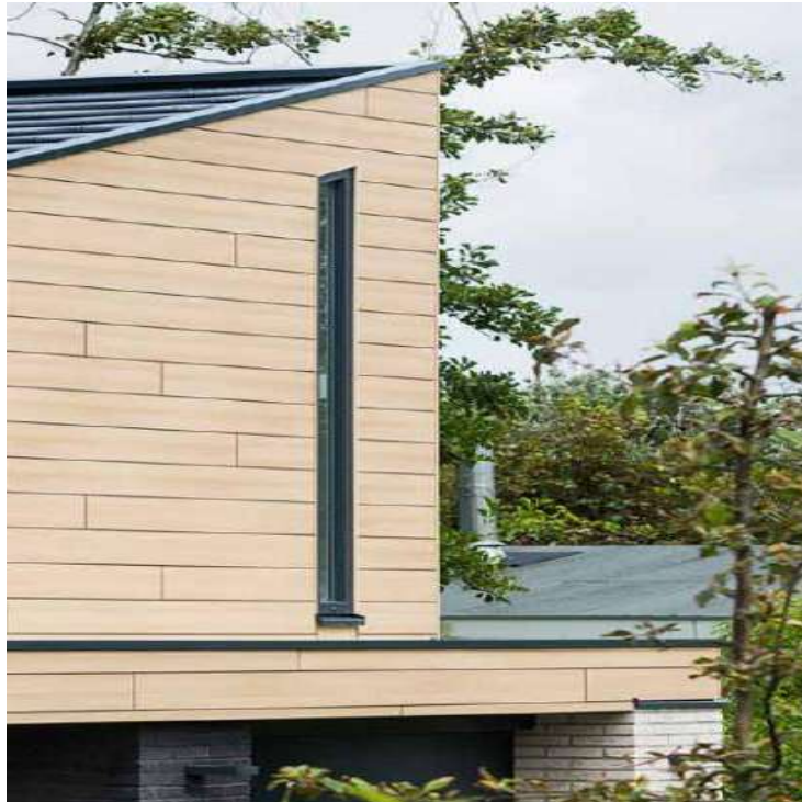
Slika 19: Fasadna obloga HPL pločama (Izvor:[21])
