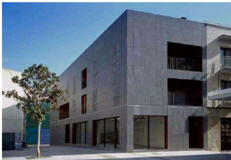
Slika 13: Fasadna obloga kamenim pločama (Izvor:[11])
