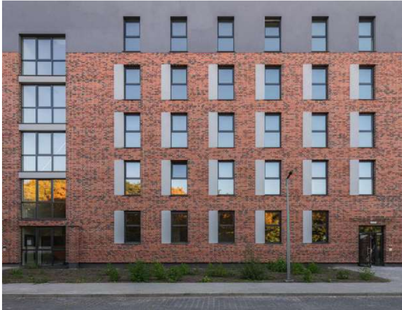
Slika 10: Fasadna obloga klinker opekom ( Izvor:[12] )
