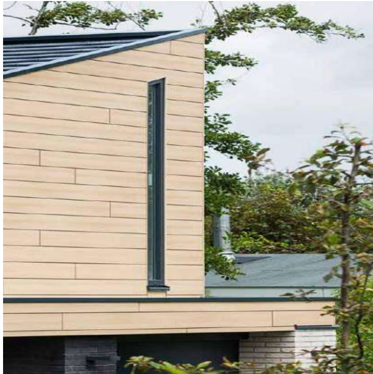
Slika 19: Fasadna obloga HPL pločama (Izvor:[21])
