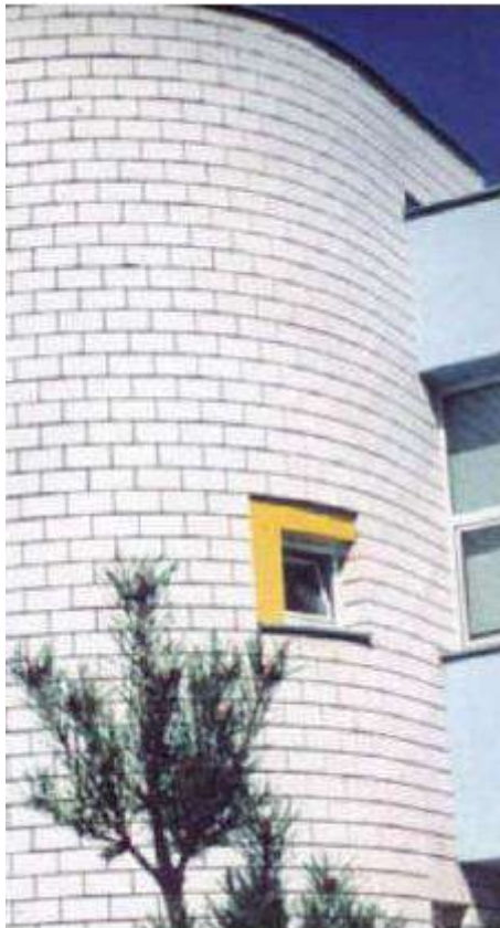
Slika 11: Fasadna obloga silikatnom opekom ( Izvor:[11] )
