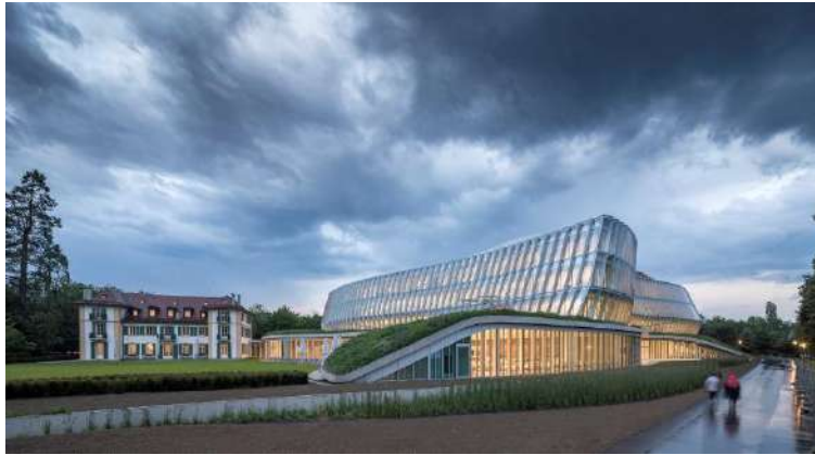
Slika 51: Vanjski izgled fasadnog sustava (Izvor: [51])
