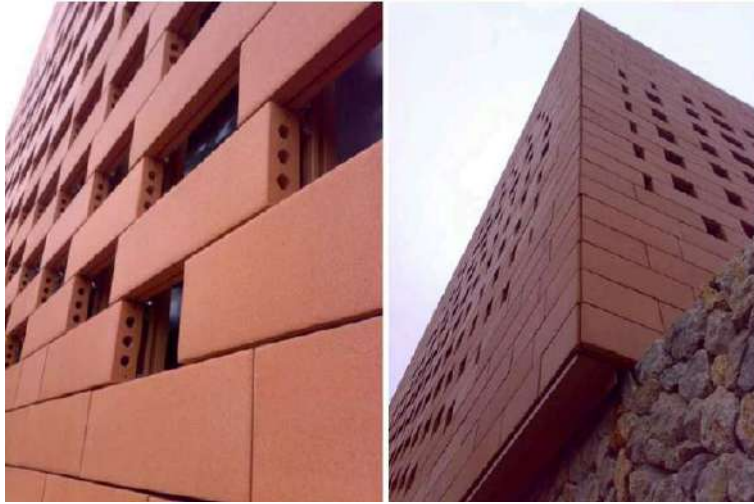
Slika 15: Fasadna obloga terracotta pločama (Izvor:[11])
