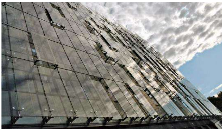
Slika 28: Primjer dvostruke ventilirane staklene fasade ( Izvor:[3] )
