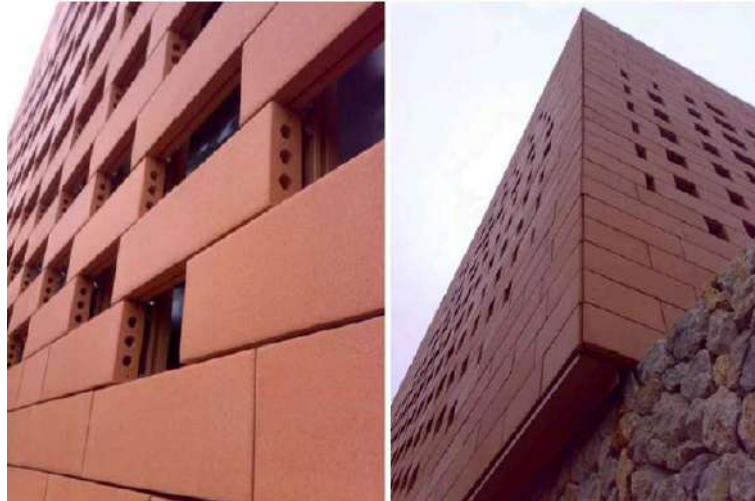
Slika 15: Fasadna obloga terracotta pločama (Izvor:[11])
