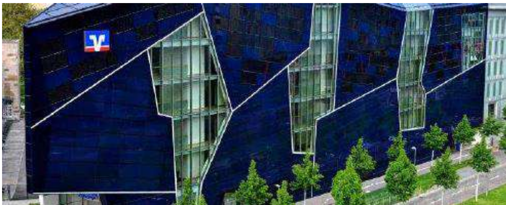
Slika 23: Fasadna obloga fotonaponskim ćelijama (Izvor:[26])
