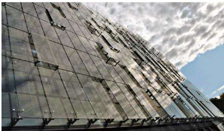
Slika 28: Primjer dvostruke ventilirane staklene fasade ( Izvor:[3] )
