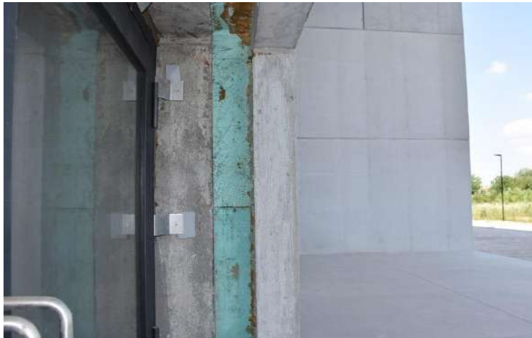
Slika 35: Vanjska obloga donjeg betonskog dijela (Izvor:[40])
