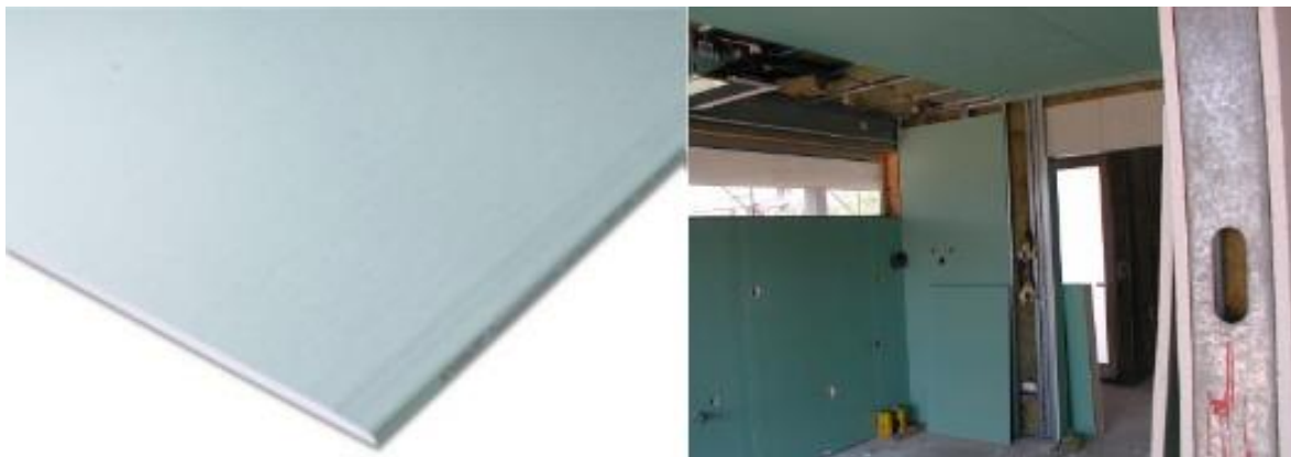
Slika 6.: Gipsana ploča tip H i njena aplikacija (Izvor: [2])
