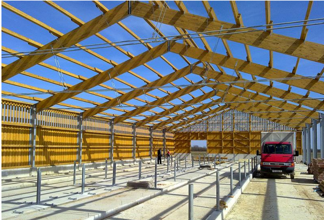
Slika 3.3. Krovna konstrukcija od LLD [9]
