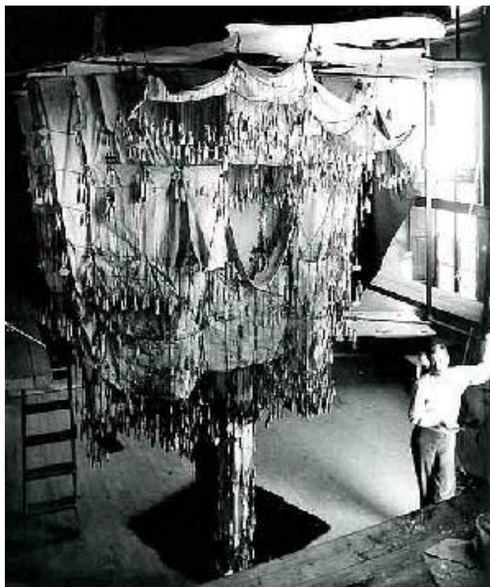
Slika 19.: Viseći model crkve u Coloniji Gúell, s ispunom od tkanine (Izvor: [23])
