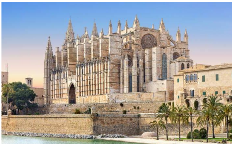
Slika 11.: Katedrala u Palma de Mallorci, s jednim od najvećih gotičkih kontrafornih sustava (Izvor: [14])
