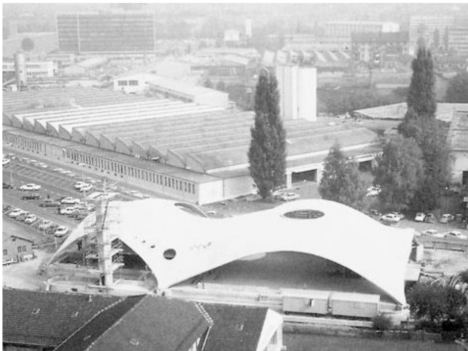
Slika 26.: Islerova zgrada tvornice Sicli u Ženevi (Izvor: [31])
