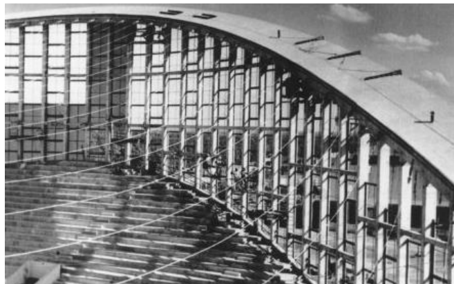
Slika 30.: Čelični kabela u fazi izgradnje Dorton Arene (Izvor: [35])
