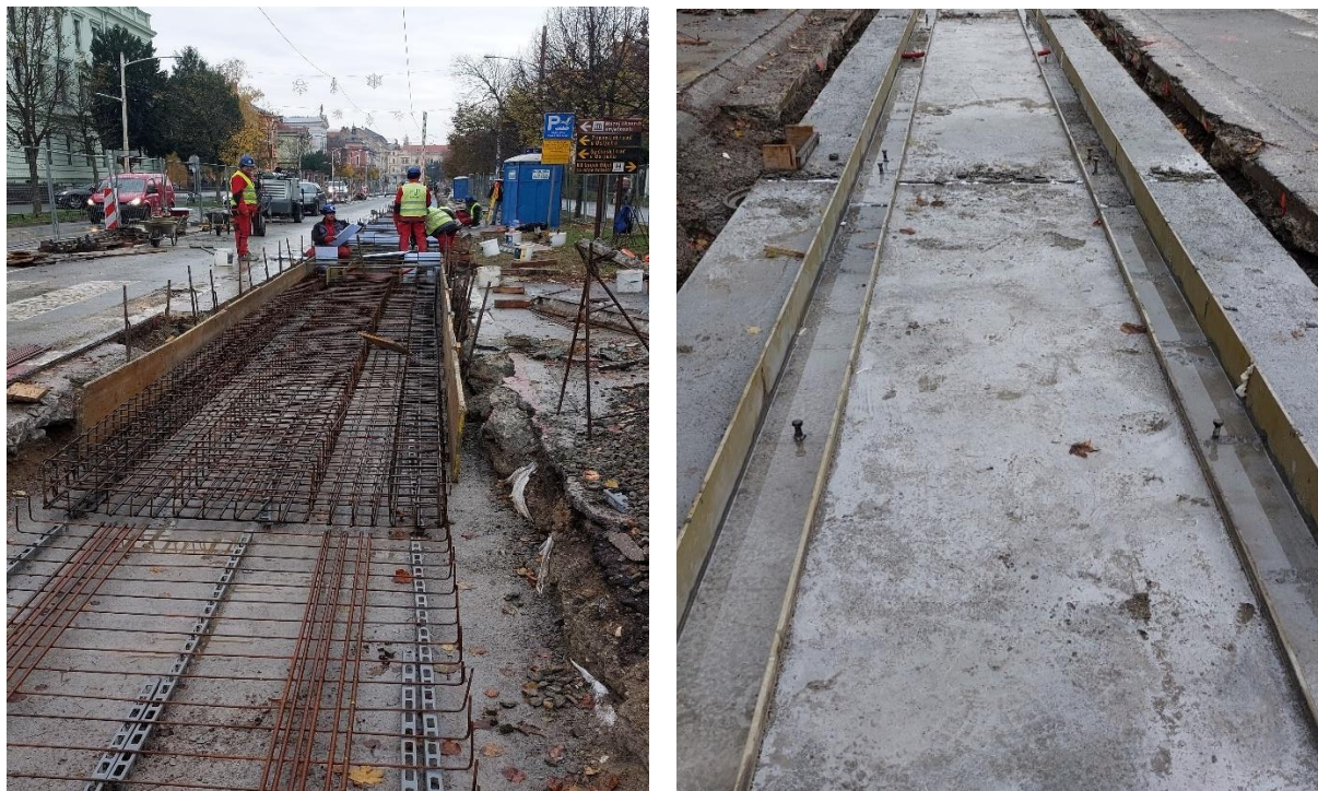
Slika 18.: Postavljanje AB ploče u Osijeku
