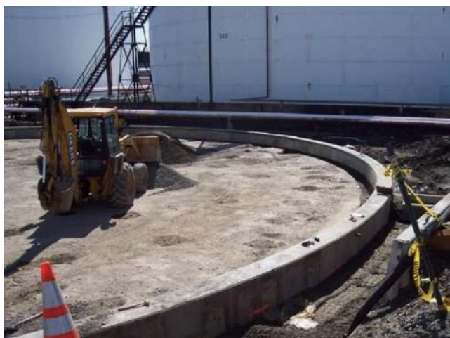
Slika 19: Temelj u obliku betonskog prstenastog zida
