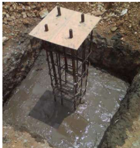
Slika 20: Temelj nosača povišenog spremnika
