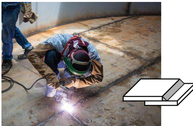
Slika 28: Preklopno zavarivanje ploča dna spremnika
