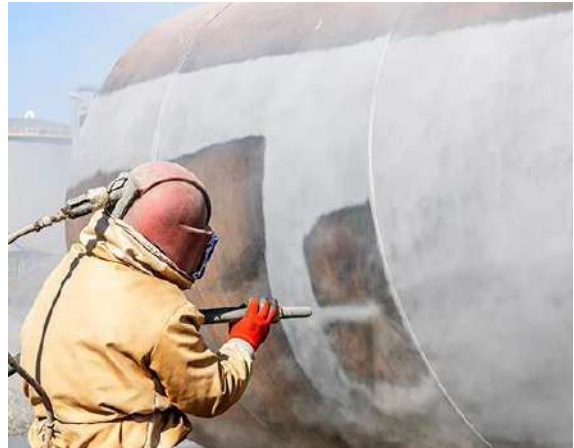
Slika 22: Pjeskarenje
