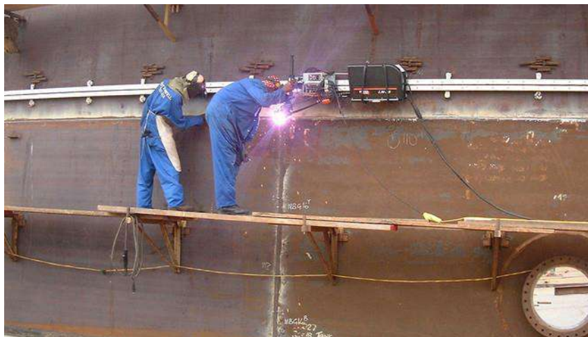
Slika 26: Zavarivanje dijelova spremnika
