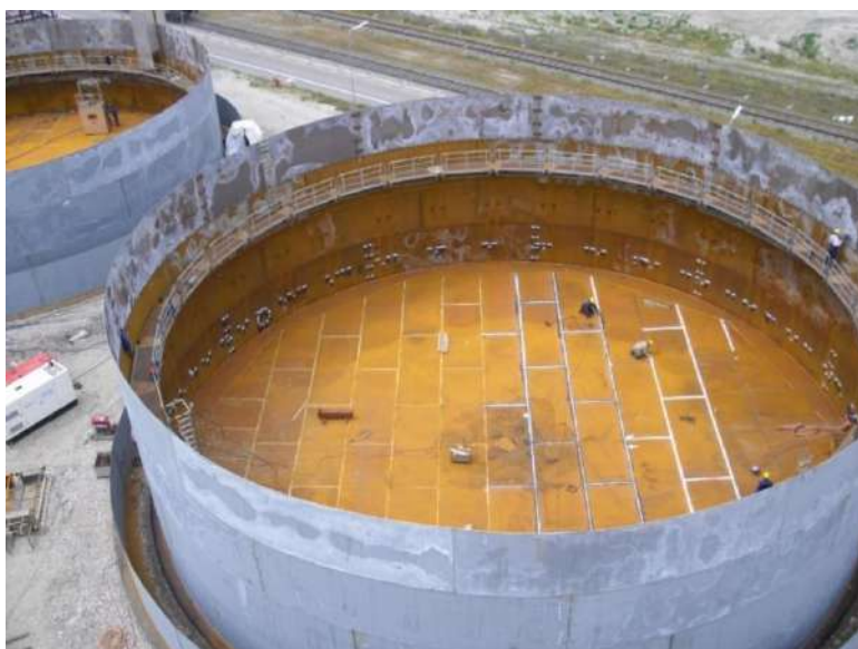
Slika 27: Raspored pravokutnih ploča dna spremnika
