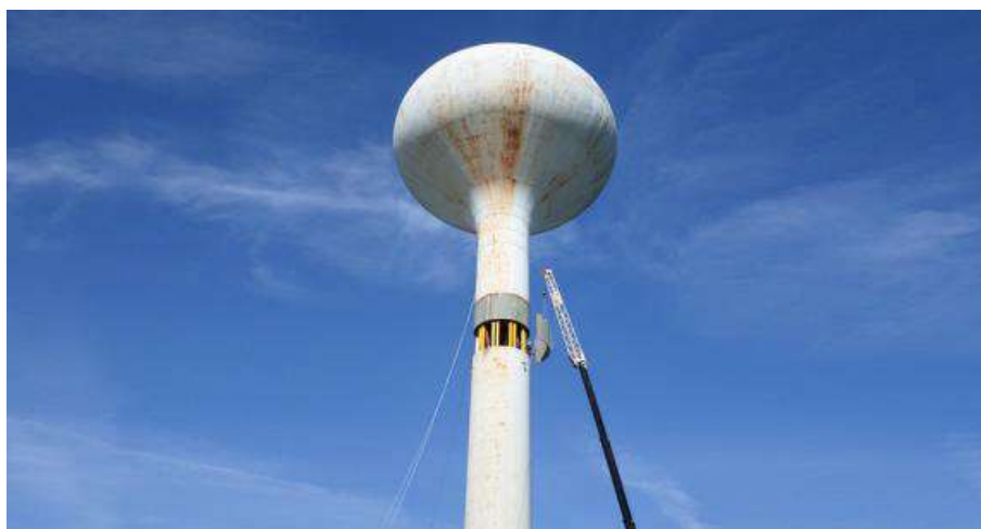
Slika 32: Montiranje spremnika na centralnom nosaču
