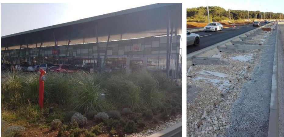
Slika 12.: Infiltracijska retencija u sklopu trgovačkog centra te izgradnja infiltracijskog jarka, Pula (Izvor: [1])
