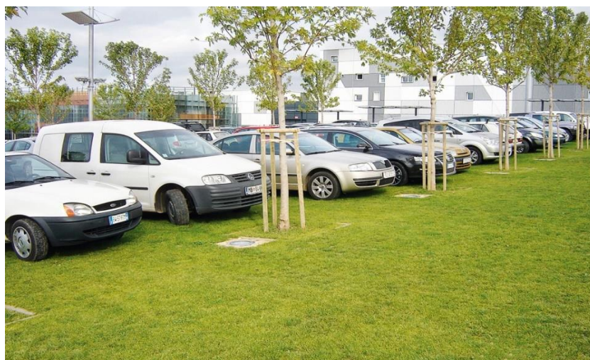
Slika 3.: Travnate rešetke na parkiralištu (Izvor: [2])
