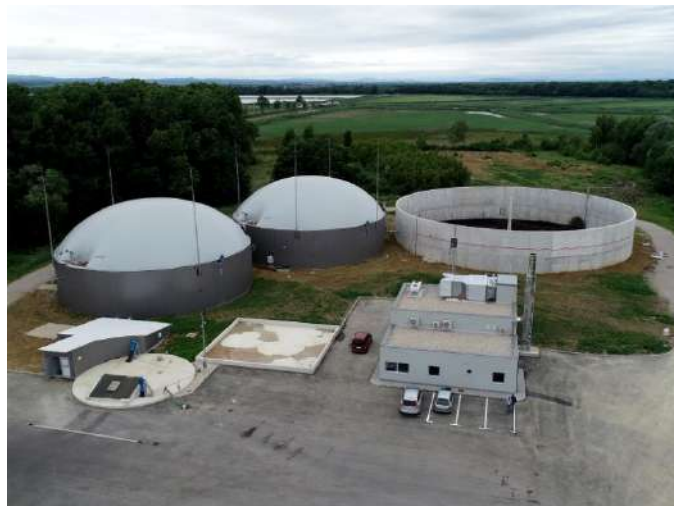
Slika 5. Spremnici za skladištenje bioplina
