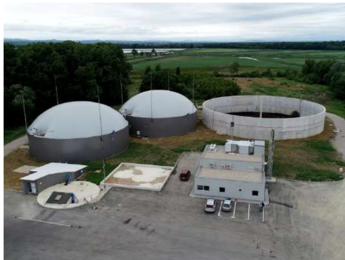
Slika 5. Spremnici za skladištenje bioplina
