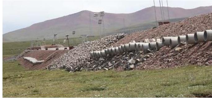
Slika 8 Ventilacijske cijevi (Izvor: [9])
