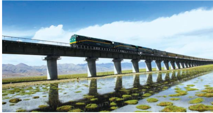
Slika 12 Suhi most kojim se izbjegava kontakt kolosjeka i permafrosta (Izvor: [8]).
