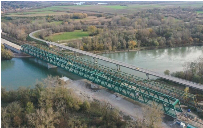
Slika 33. Željeznički most Drava na Botovu [14]
