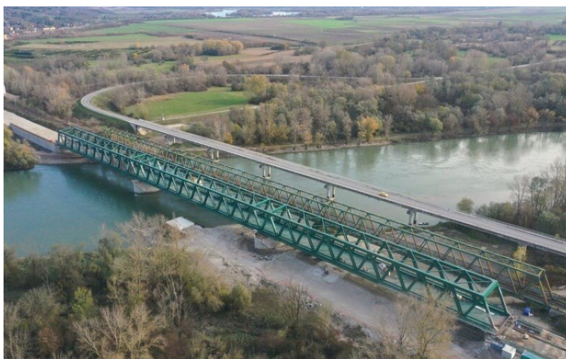
Slika 33. Željeznički most Drava na Botovu [14]
